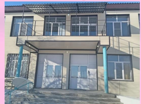
МОУ Манкечурская СОШ после капитального ремонта
