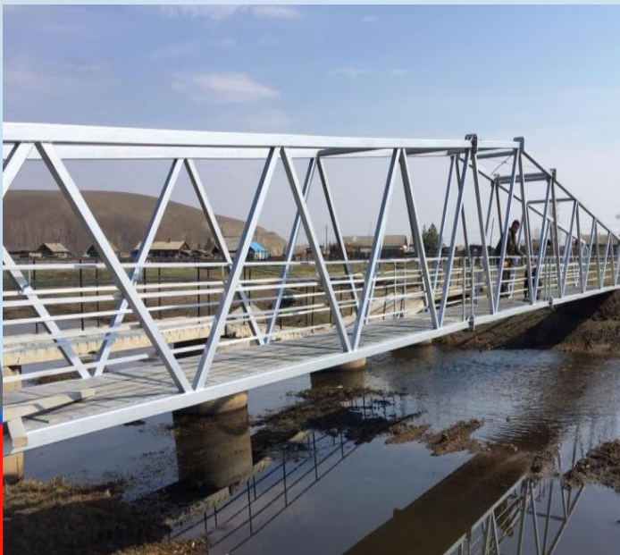
Установка пешеходных мостов
