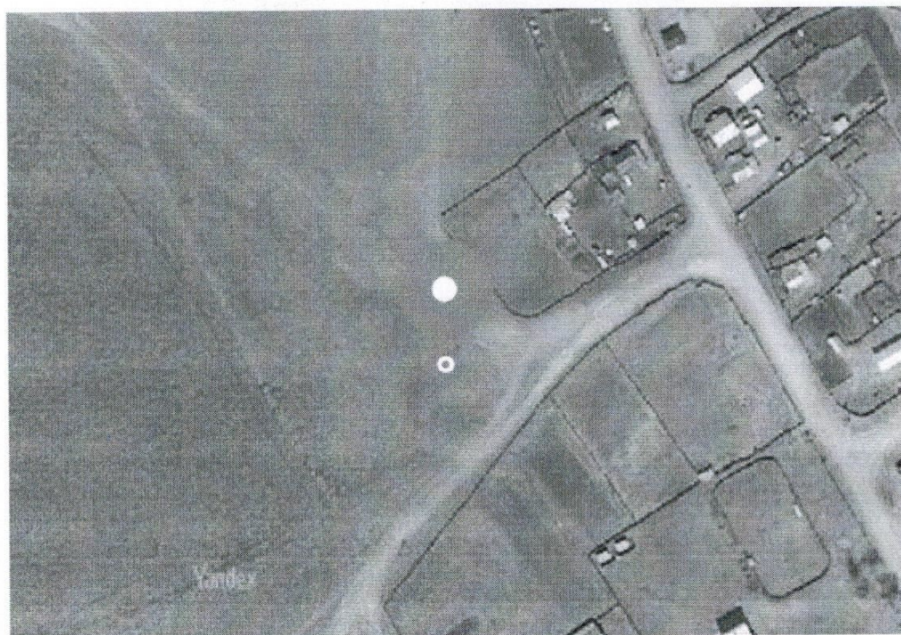
● - Площадка твердых бытовых отходов (ТКО)
