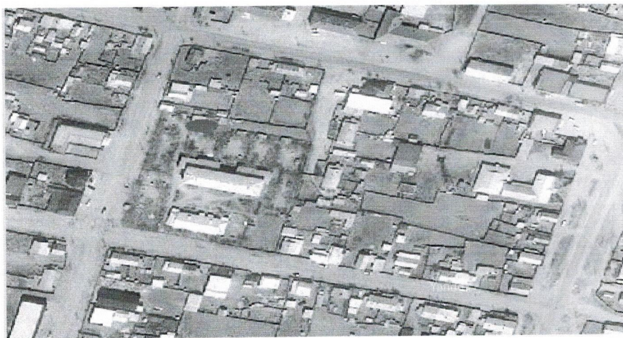
■ - Площадка твердых бытовых отходов (ТКО)
