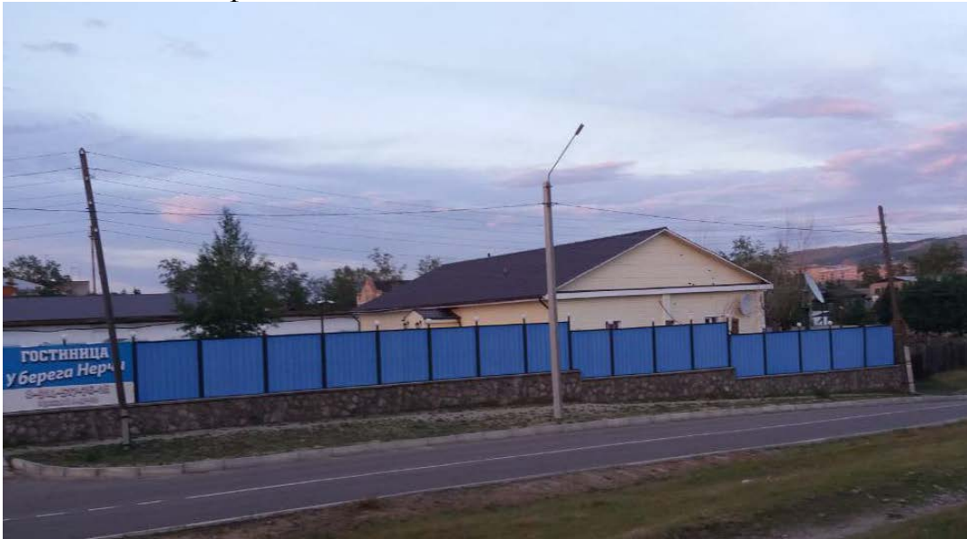
Фото 1. ОКН "Дом жилой", Ярославского,4. Современное состояние. Главный и боковой фасады
