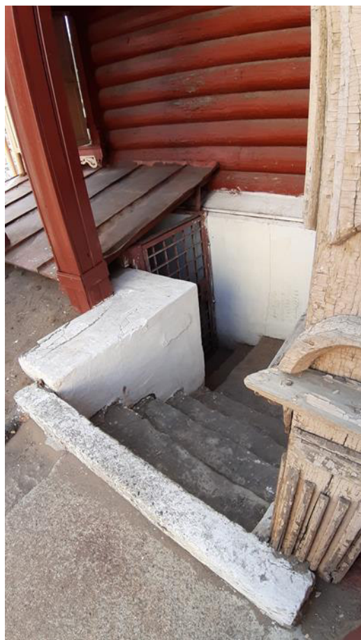
Вход в подвал на юго-восточном фасаде
