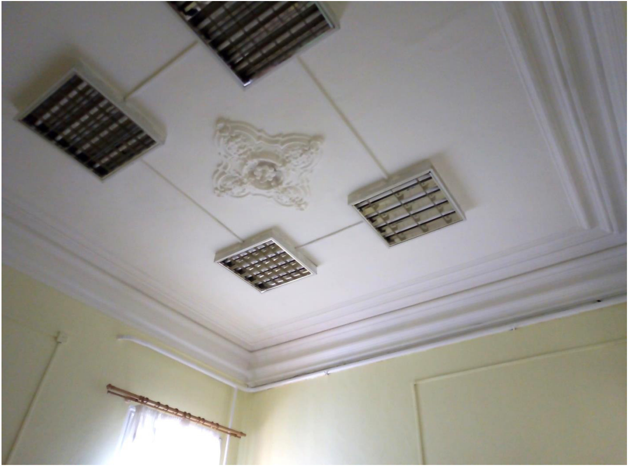
1-й этаж пом. 10
