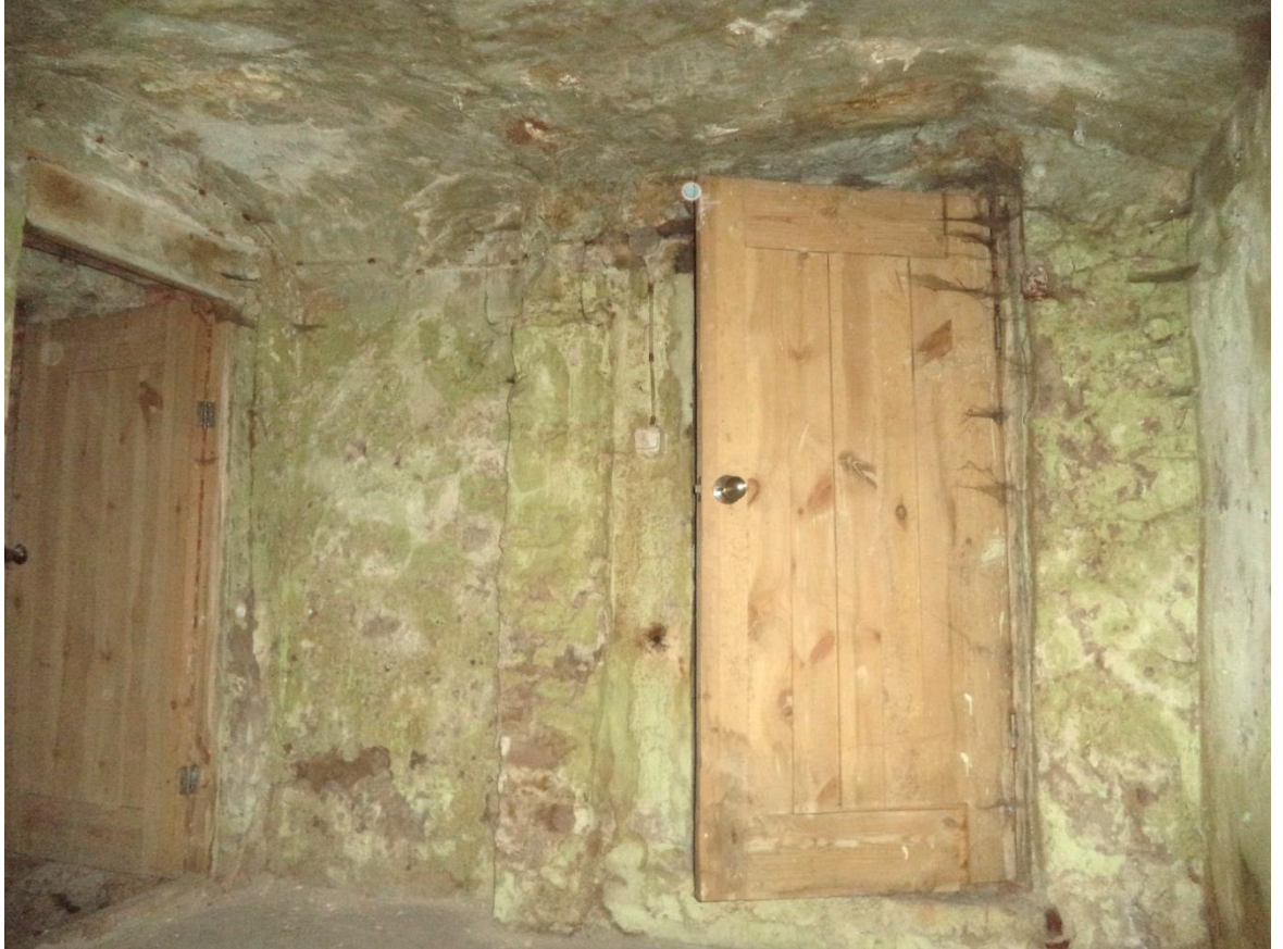
Свод перекрытия помещения 3.
