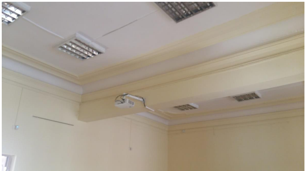
1-й этаж пом. 4
