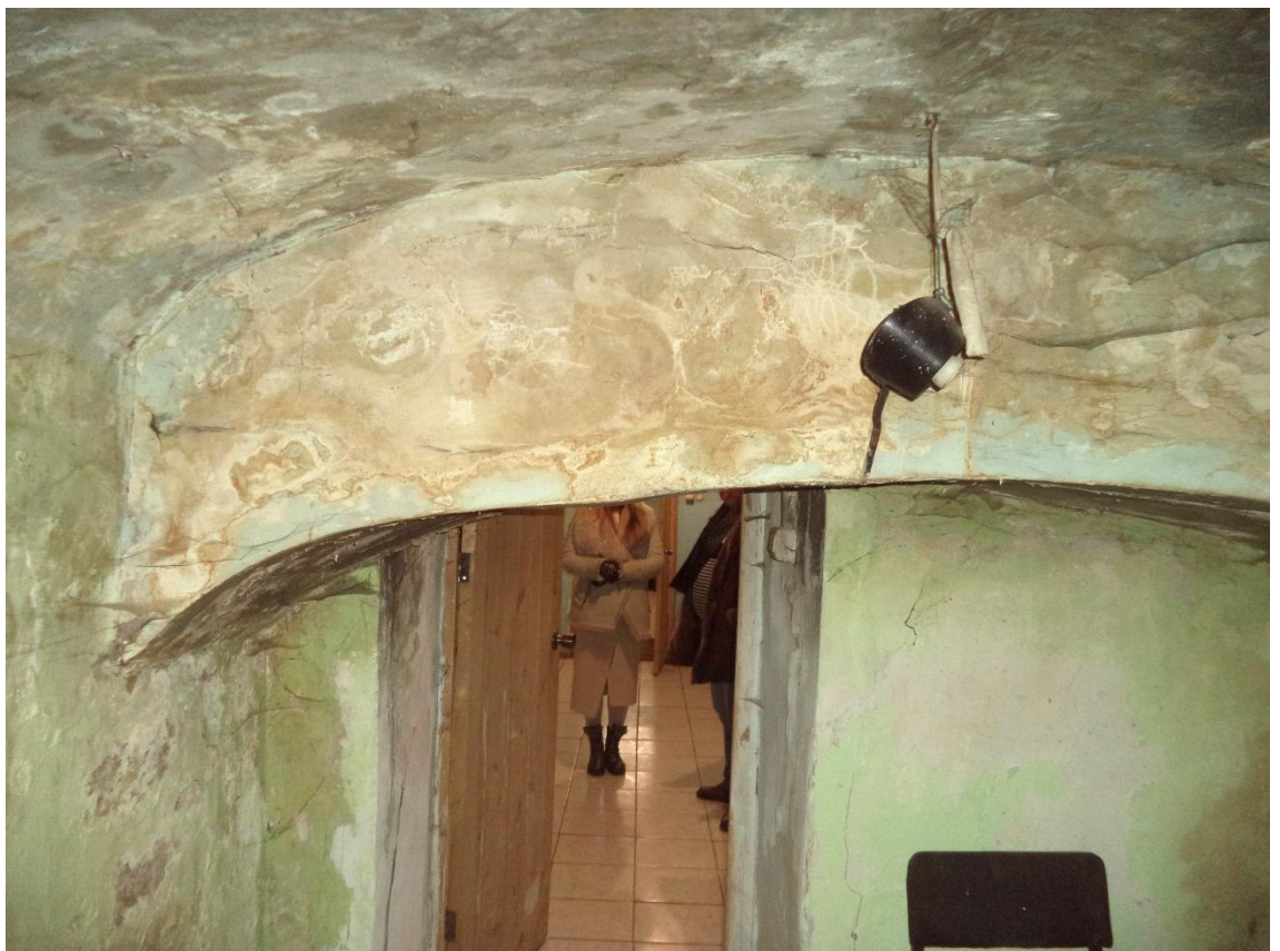
Арка между помещениями 2 и 3.
