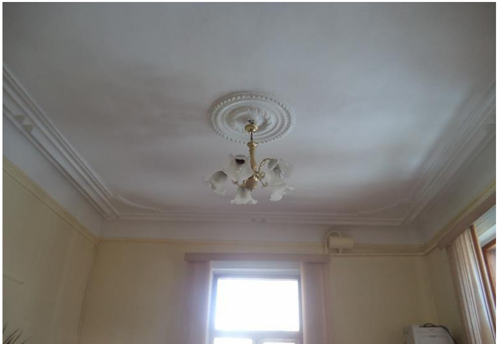
2-й этаж пом. 4
