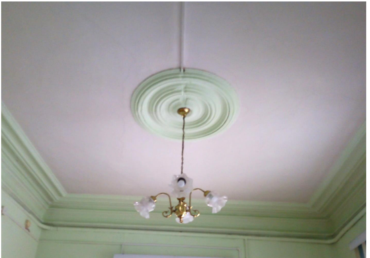
1-й этаж пом. 5
