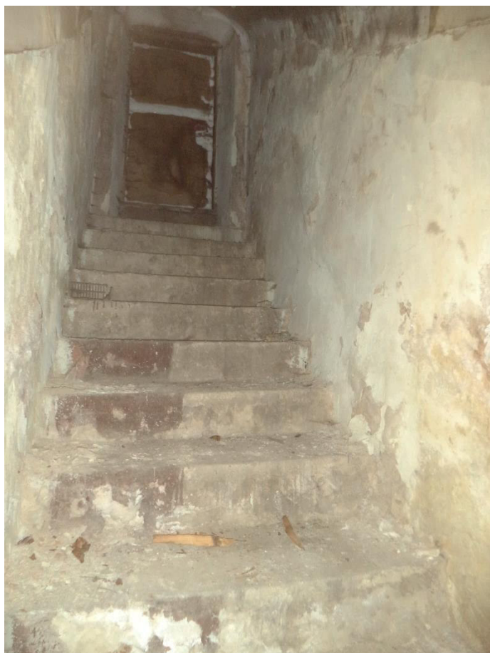
Лестница в изолированном входе в подвал.
