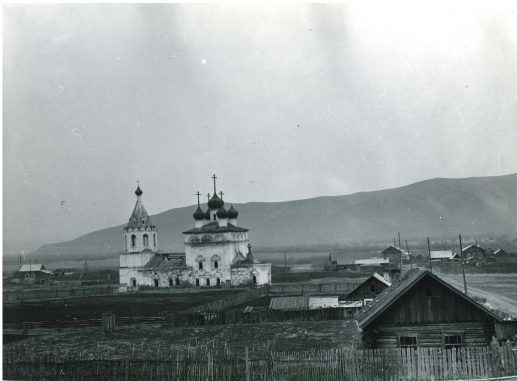
7. Южный фасад. Фото 1978 г. - представлено заказчиком экспертизы
