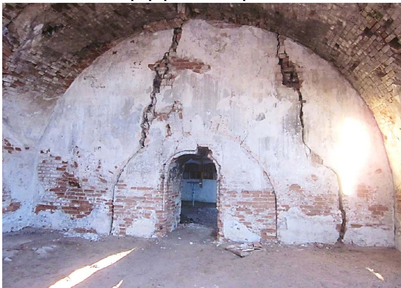
Трапезная. Восточная стена, коробовый свод
