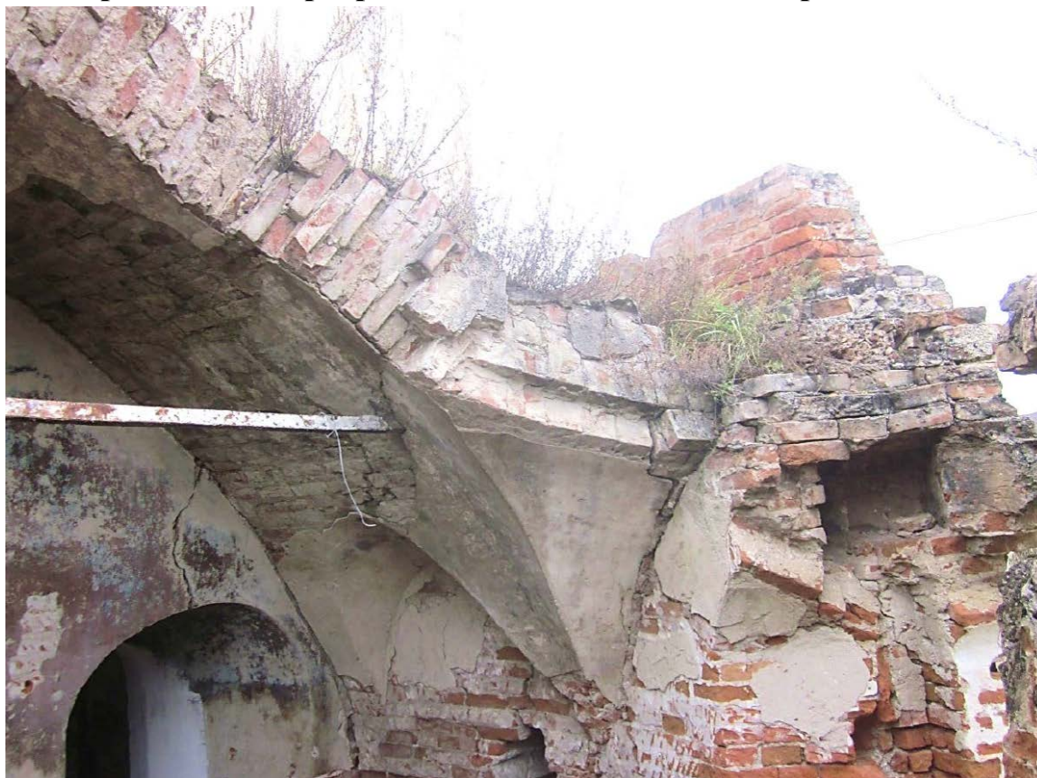
Северная часть апсиды. Сохранившаяся опорная часть
