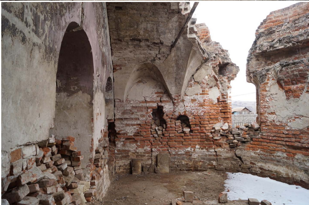
Фрагмент интерьера северной части алтарной стены
