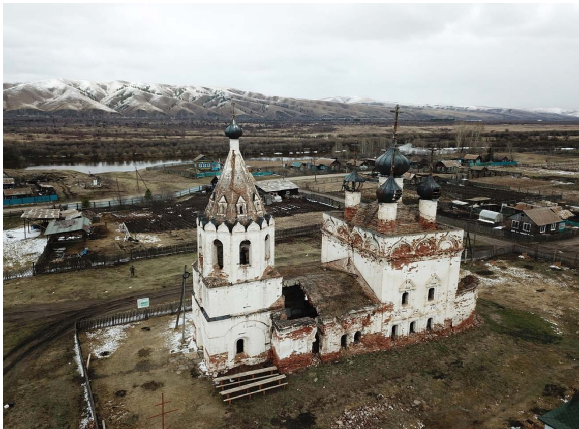
Общий вид с юго-запада
