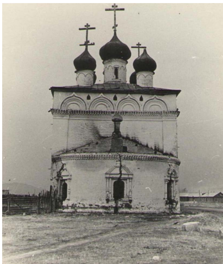
8. Восточный фасад. Фото 1978 г. – представлено заказчиком экспертизы
