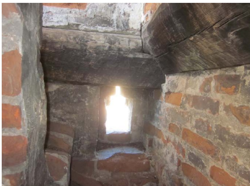
Внутренние деревянные связи 2- го яруса колокольни
