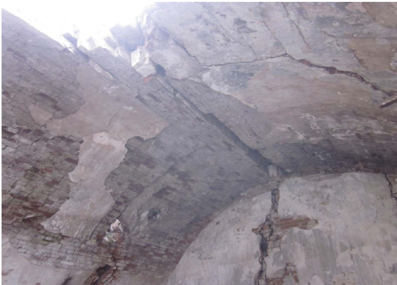
Коробовый свод трапезной
