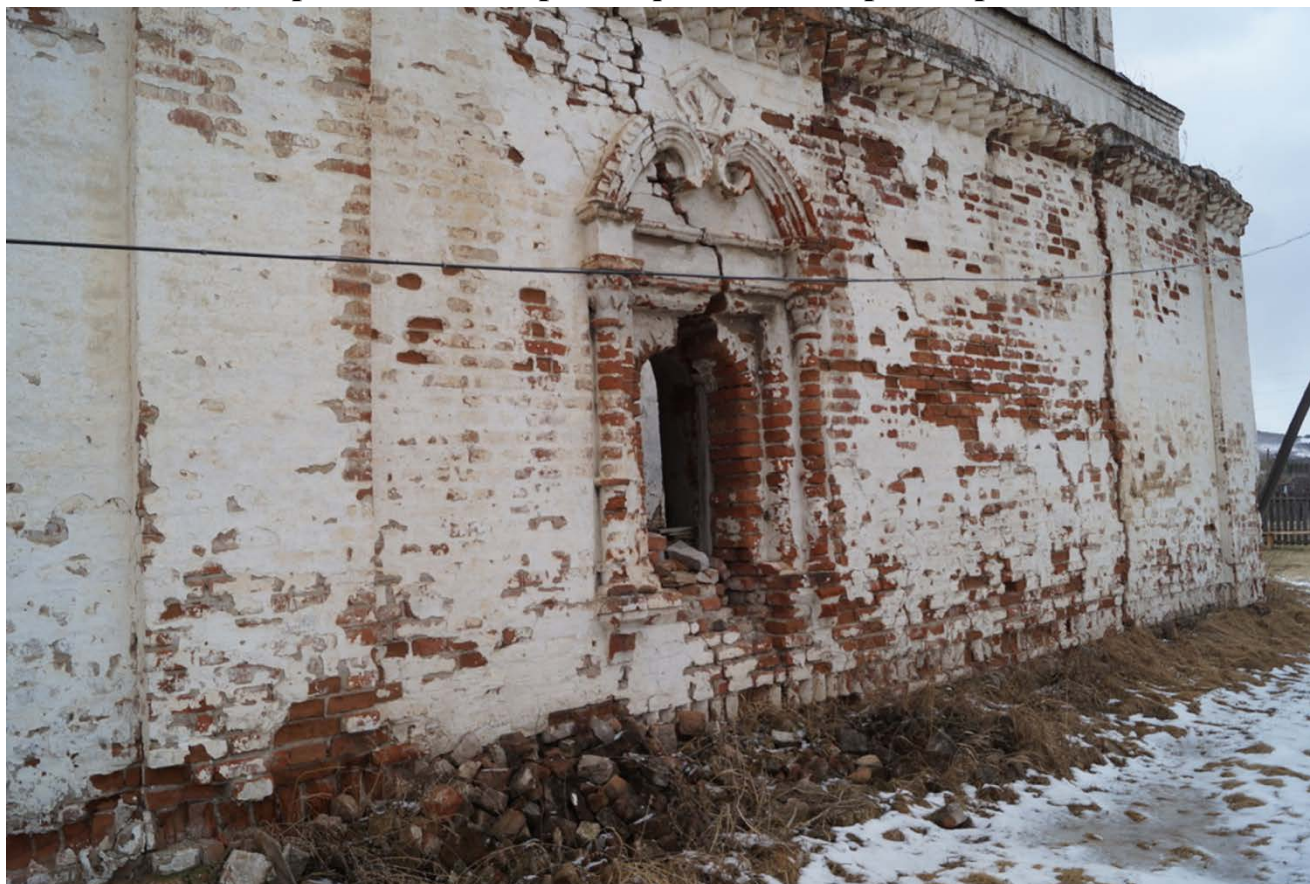
Окно северного фасада трапезной храма
