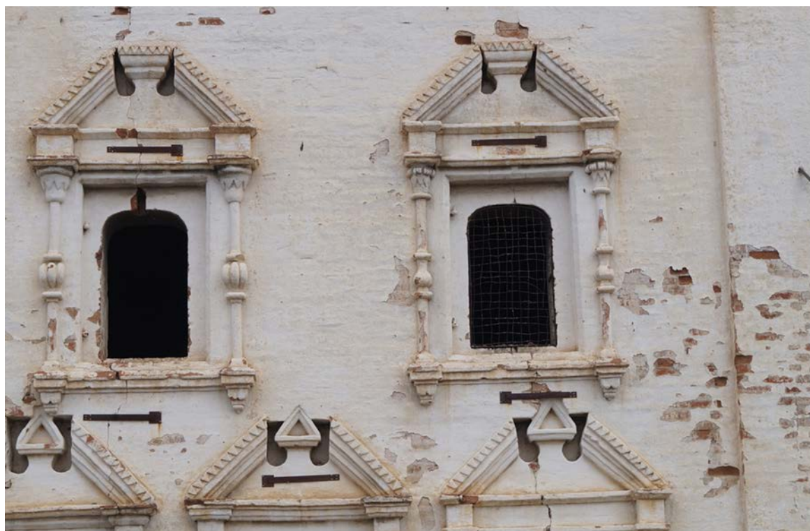
Фрагменты окон южного фасада храма
