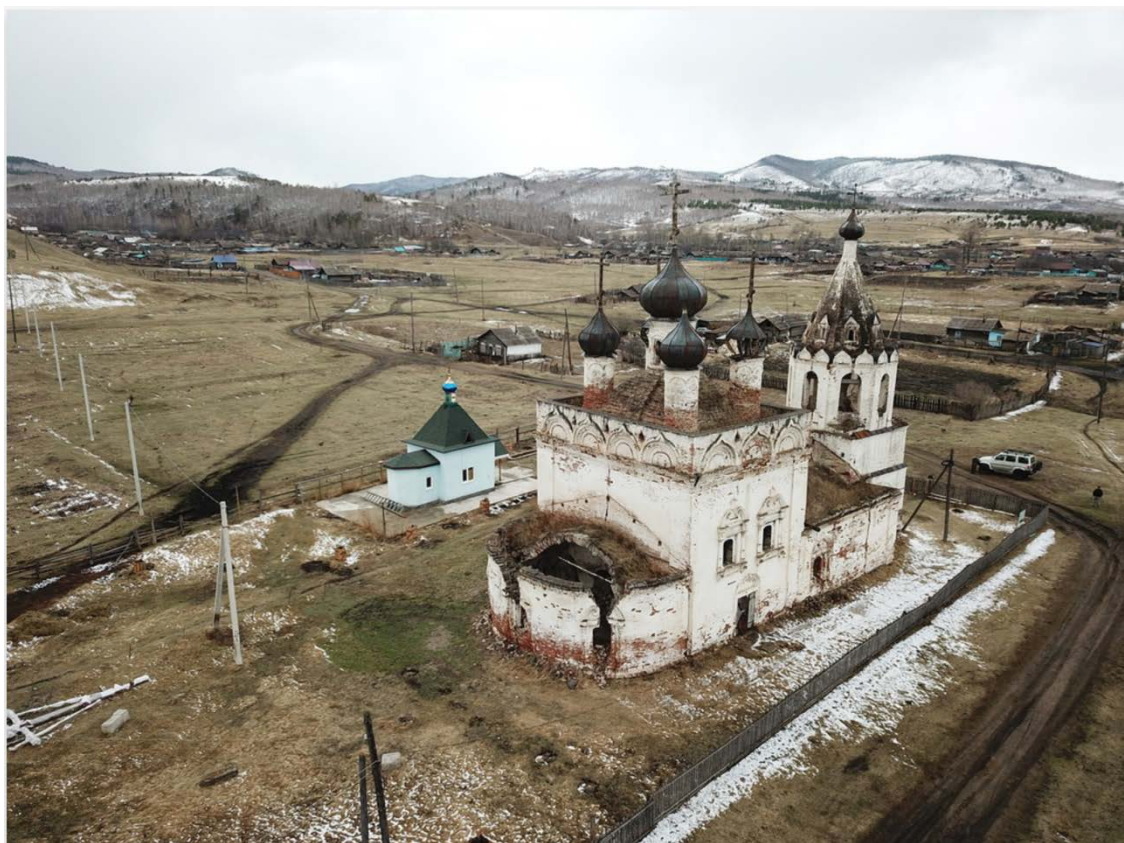
Общий вид с северо-востока
