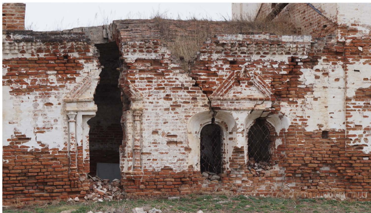
Южный фасад трапезной
