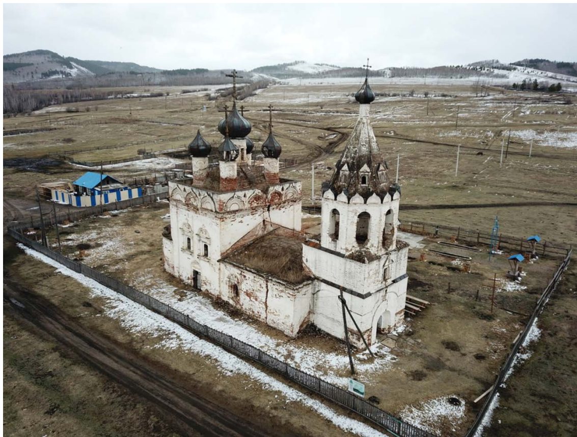
Общий вид с северо-запада
