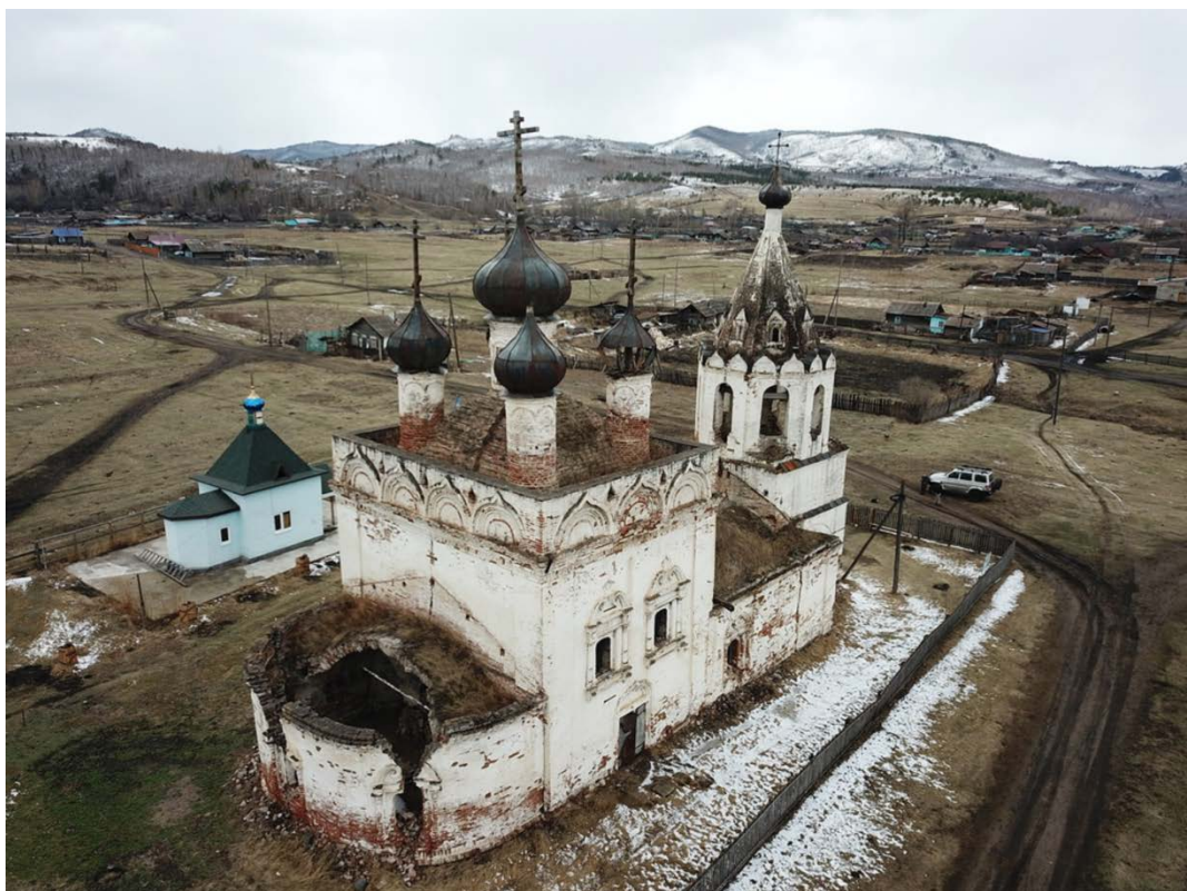
Общий вид с северо-востока
