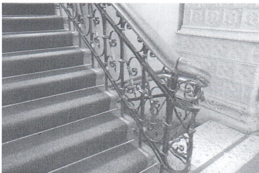
Фото 6 фрагмент парадной лестницы
