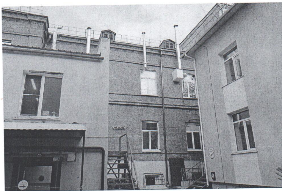
Фото 3 дворовый юго-западный объем
