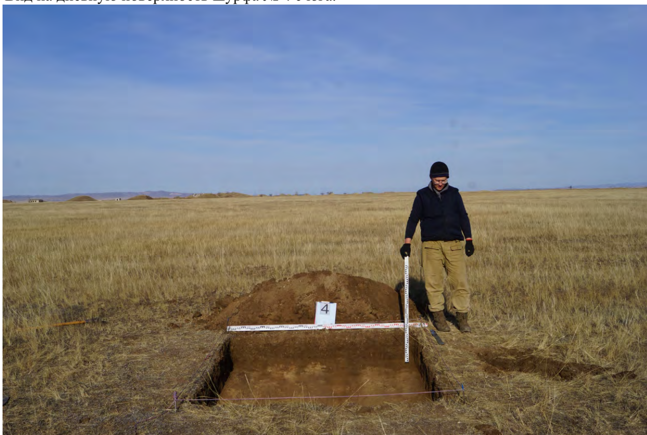
Иллюстрация № 34 (фото). Археологические полевые работы на территории земельного участка, общей площадью 192 га, отведенном под строительство солнечной электростанции расположенной по адресу: Забайкальский край, Борзинский район, в районе с. Чиндант-2-й. Вид на шурф № 4 с юга.
