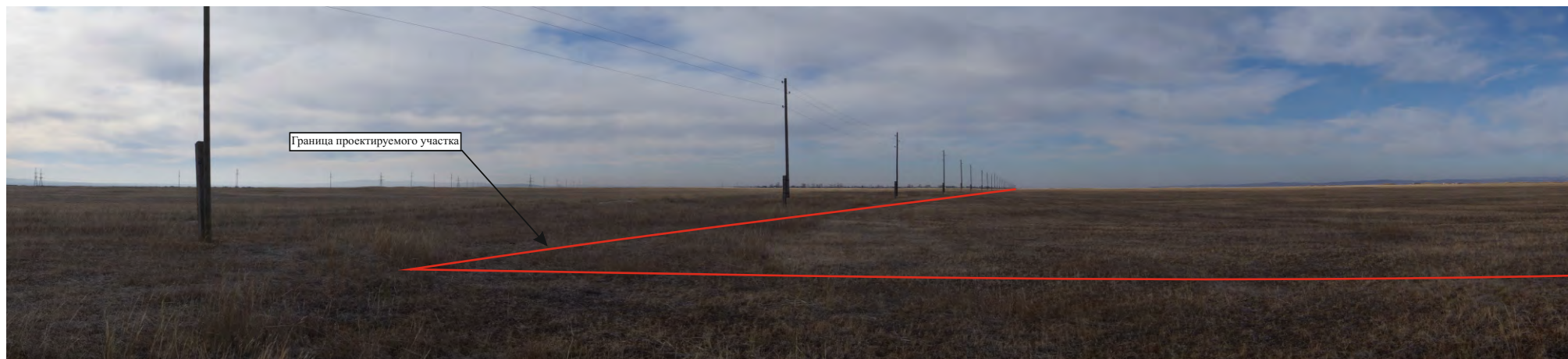
Иллюстрация № 7 (фото). Археологические полевые работы на территории земельного участка, общей площадью 192 га, отведенном под строительство солнечной электростанции расположенной по адресу: Забайкальский край, Борзинский район, в районе с. Чиндант-2-й. Вид на проектируемый участок с востоко-северо-востока. Точка фотофиксации № 1.
