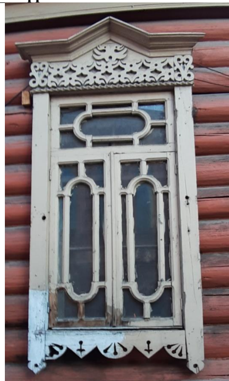
Наличник юго-восточного фасада.
