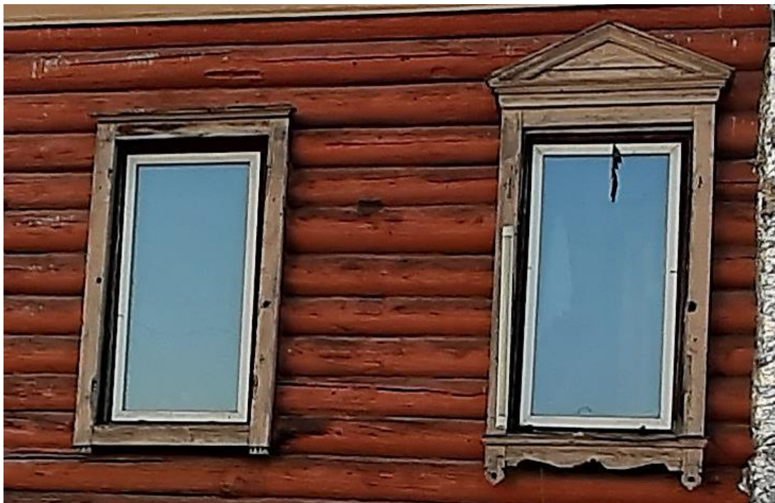
Наличники юго-западного фасада.
