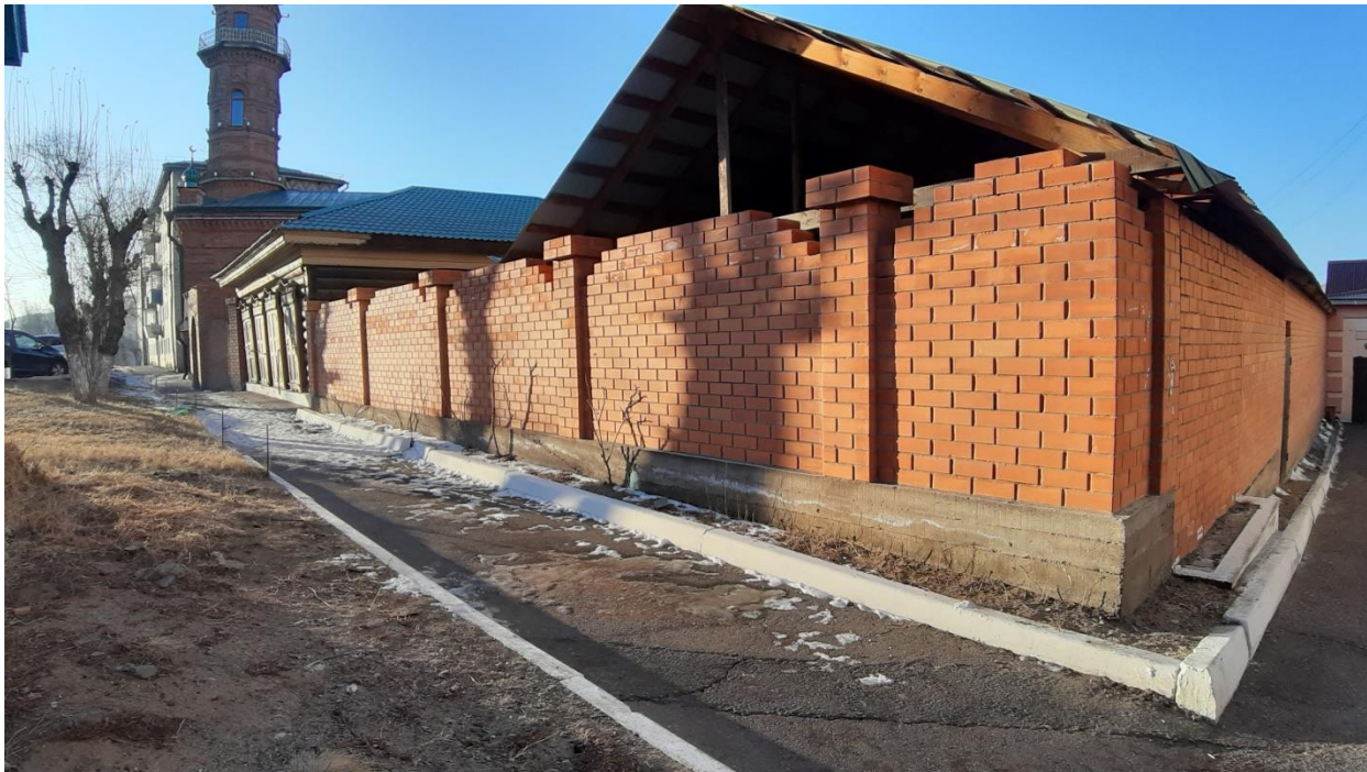
Тротуар вдоль ул. Аохина.
