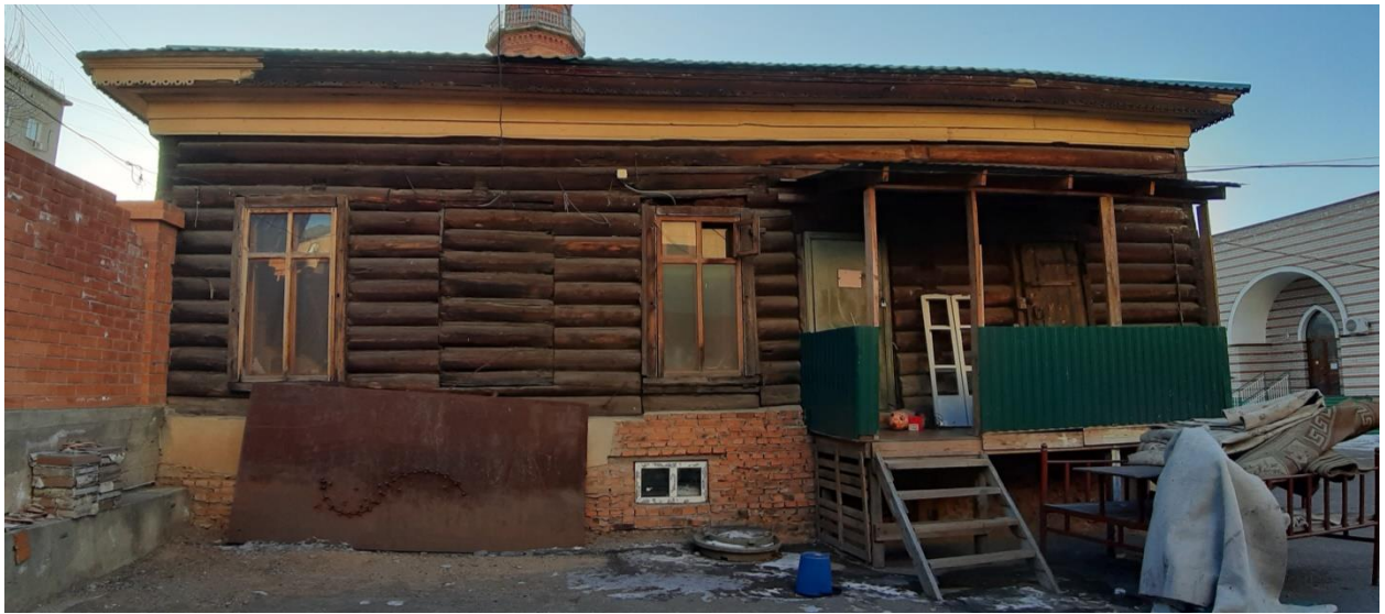
Северо- западный фасад
