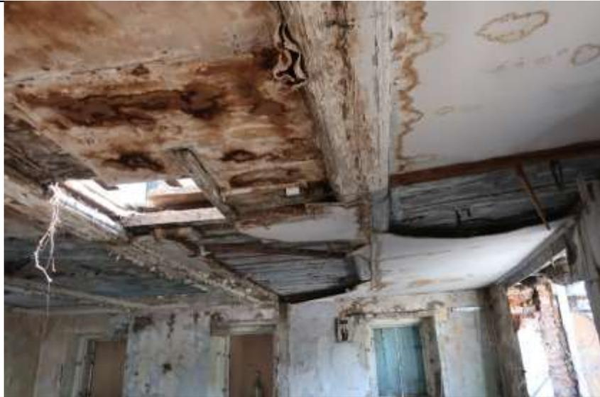
Фото 5 междуэтажное перекрытие разрушено.
