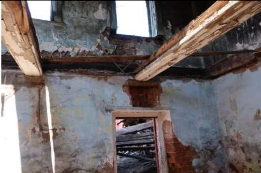
Фото 4 состояние подвала, разрушение кладки стены над проемом.
