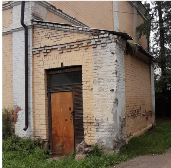
Тамбур на северо-восточном фасаде.
