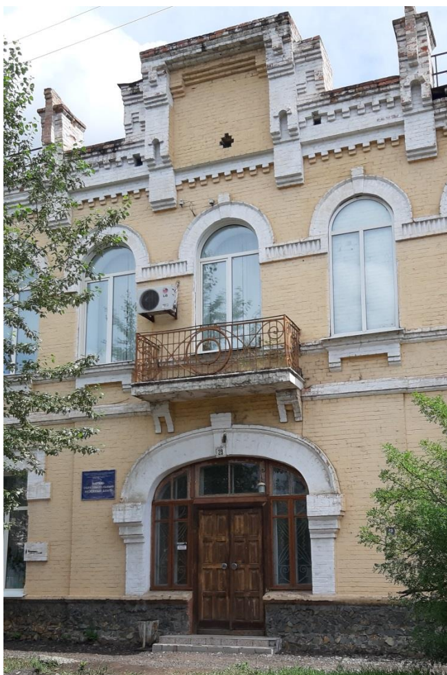
Центральная часть северо-западного фасада.
