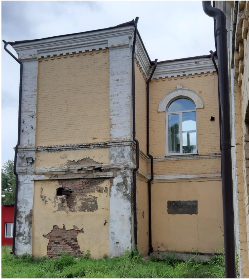
Северо-восточный фасад дворового объема и перехода.
