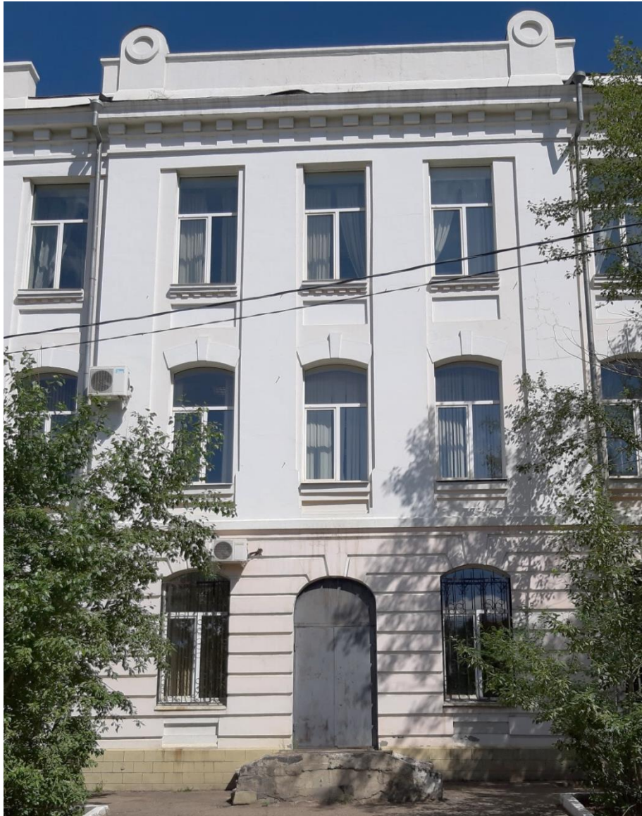
Ризалит юго-восточного фасада с парадным входом.
