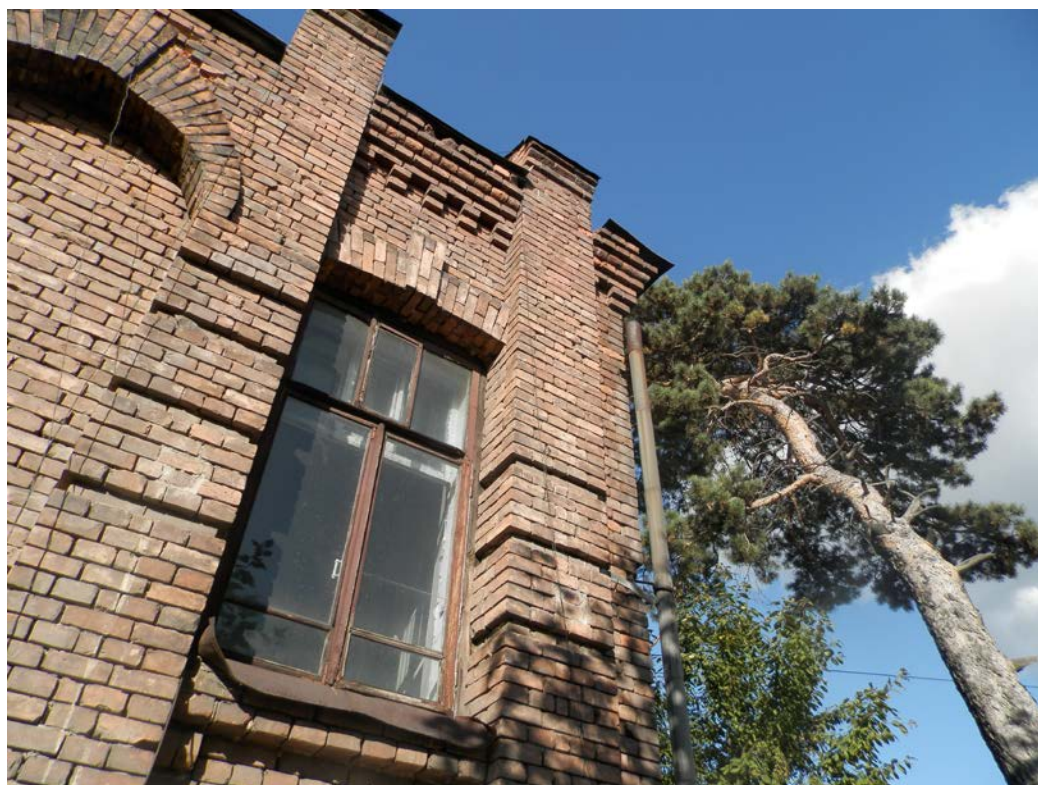
Юго-западный фасад здания. Фрагмент. Вид расстекловки.
