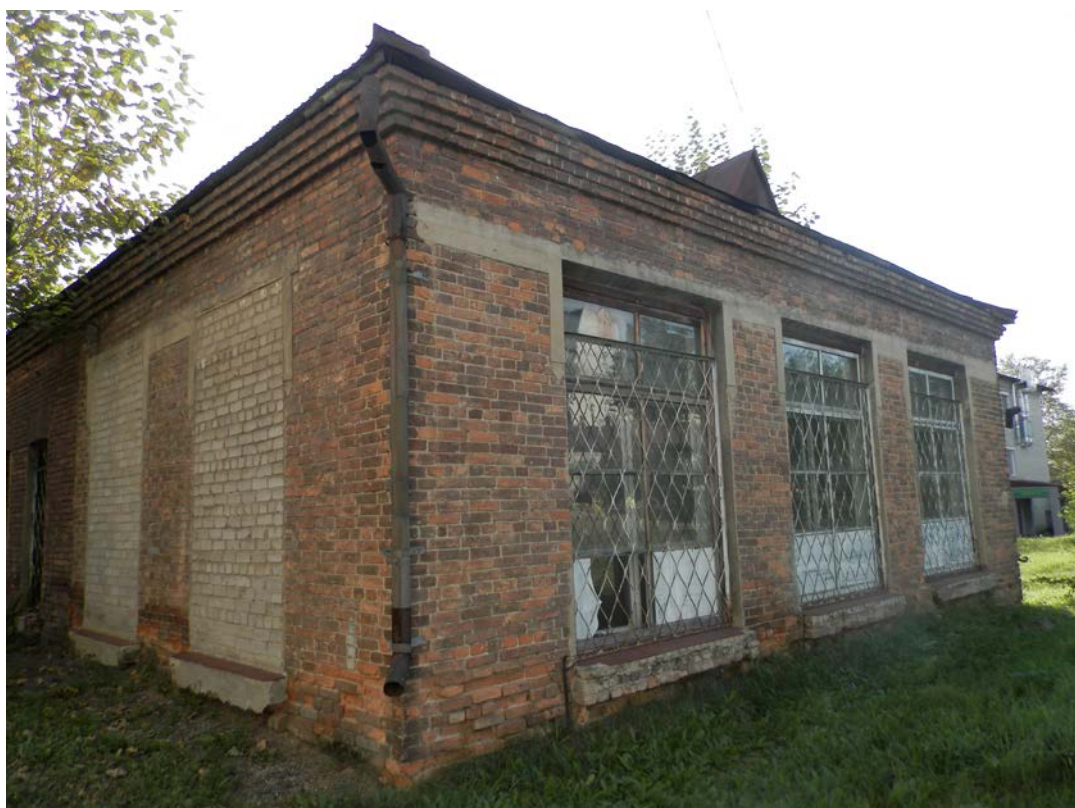
Северо-восточный фасад здания.
