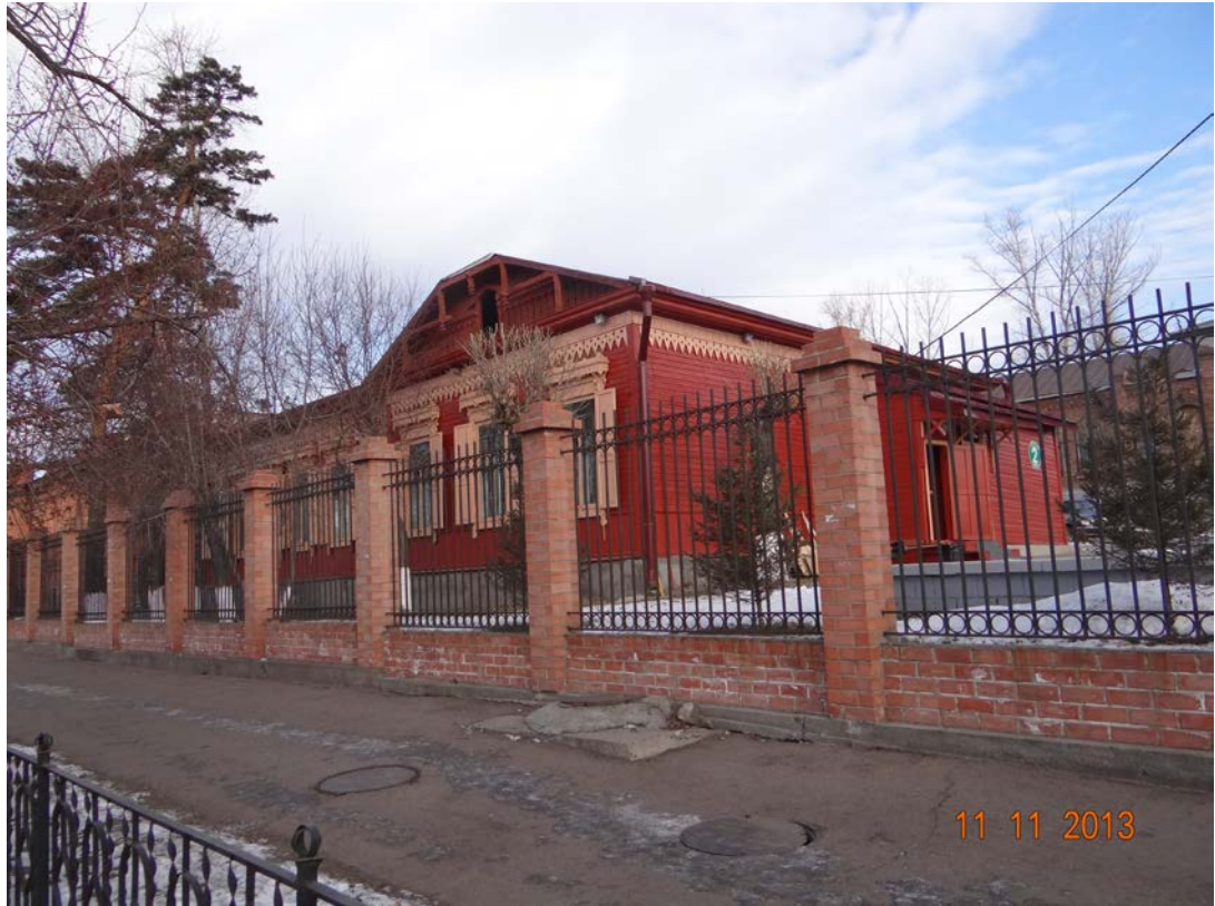
Историческое фото 2. Главный фасад строения 8. Фото выполнено в 2013 г. Автор фото неизвестен. Источник: архив государственной службы по охране объектов культурного наследия Забайкальского края.
