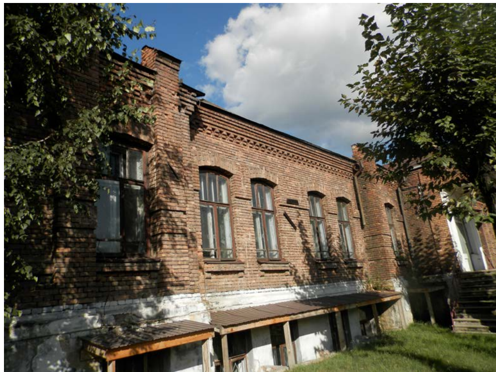
Фрагмент главного фасада здания (юго-западный фасад).
