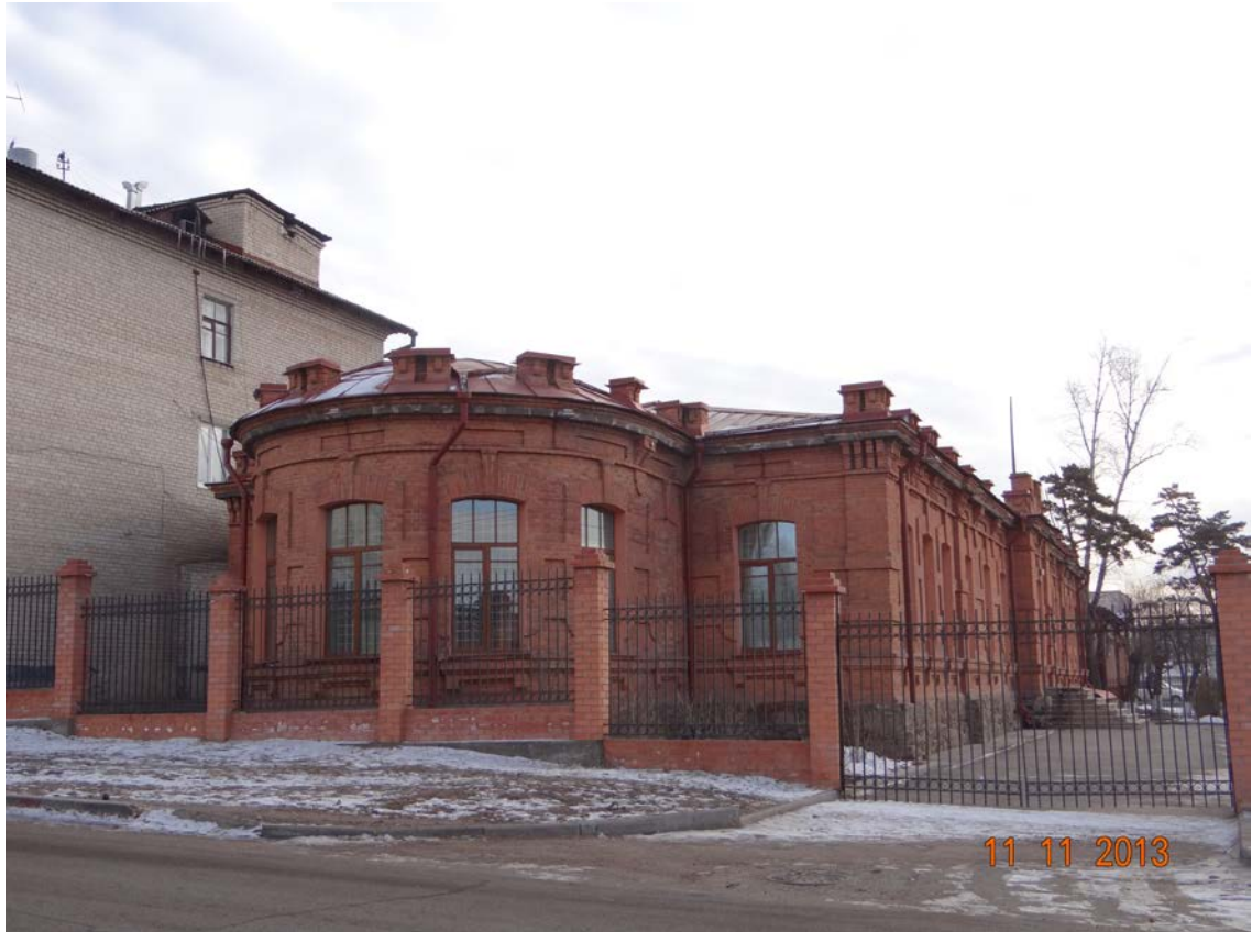
Историческое фото 3. Главный фасад строения 3. Фото выполнено в 2013 г. Автор фото неизвестен. Источник: архив государственной службы по охране объектов культурного наследия Забайкальского края.
