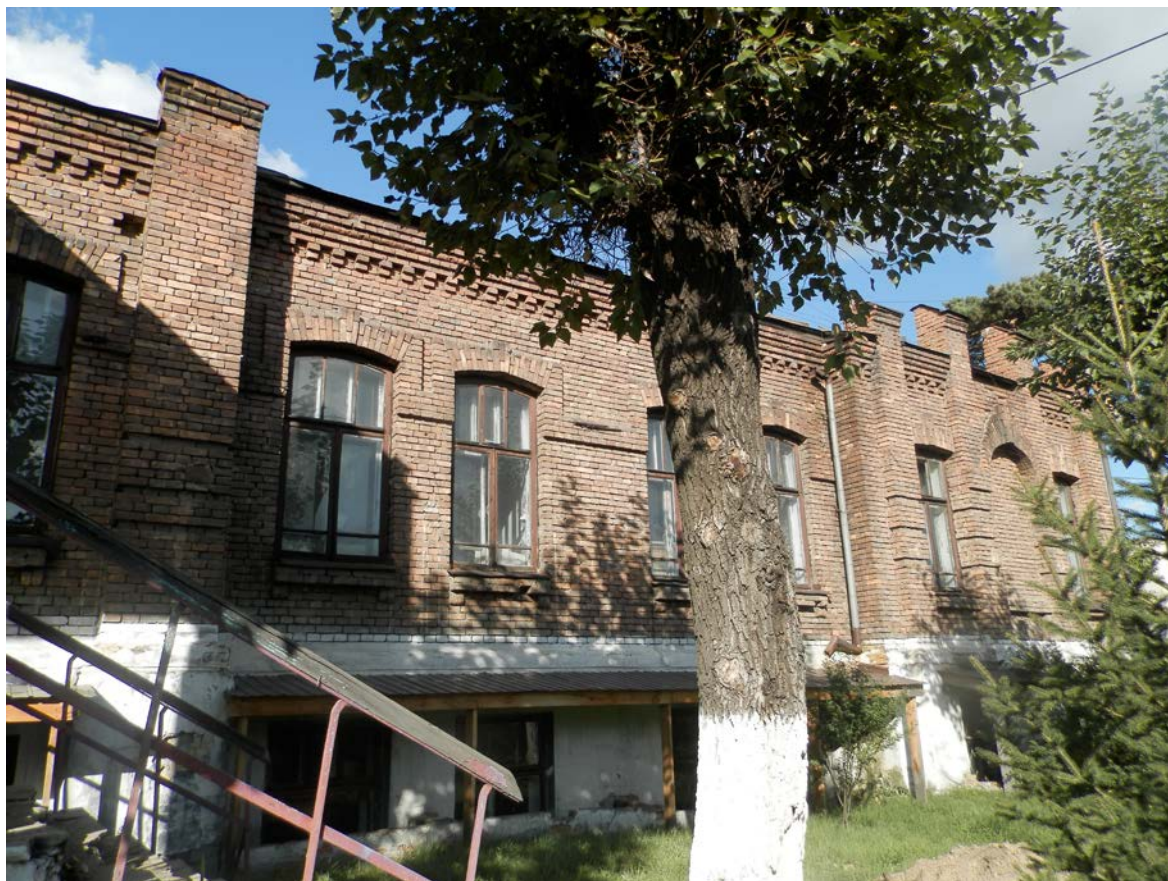
Юго-западный фасад здания. Фрагмент.
