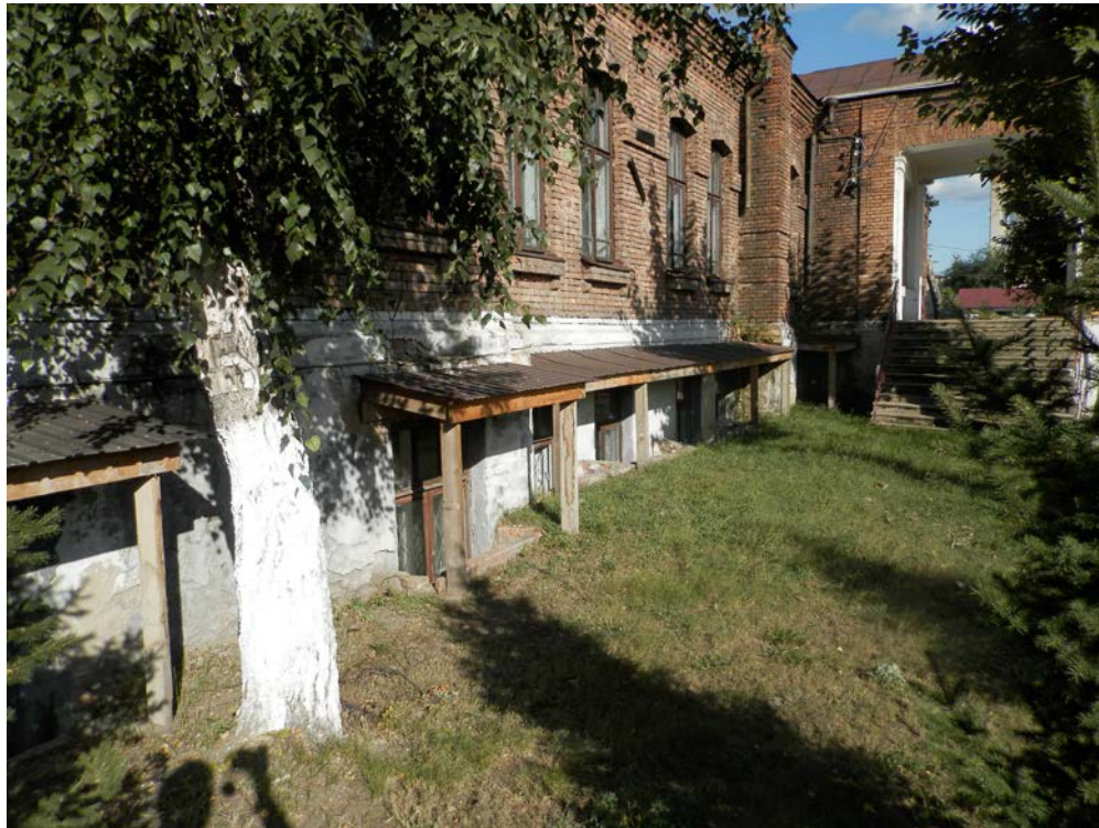
Фрагмент главного фасада здания (юго-западный фасад).
