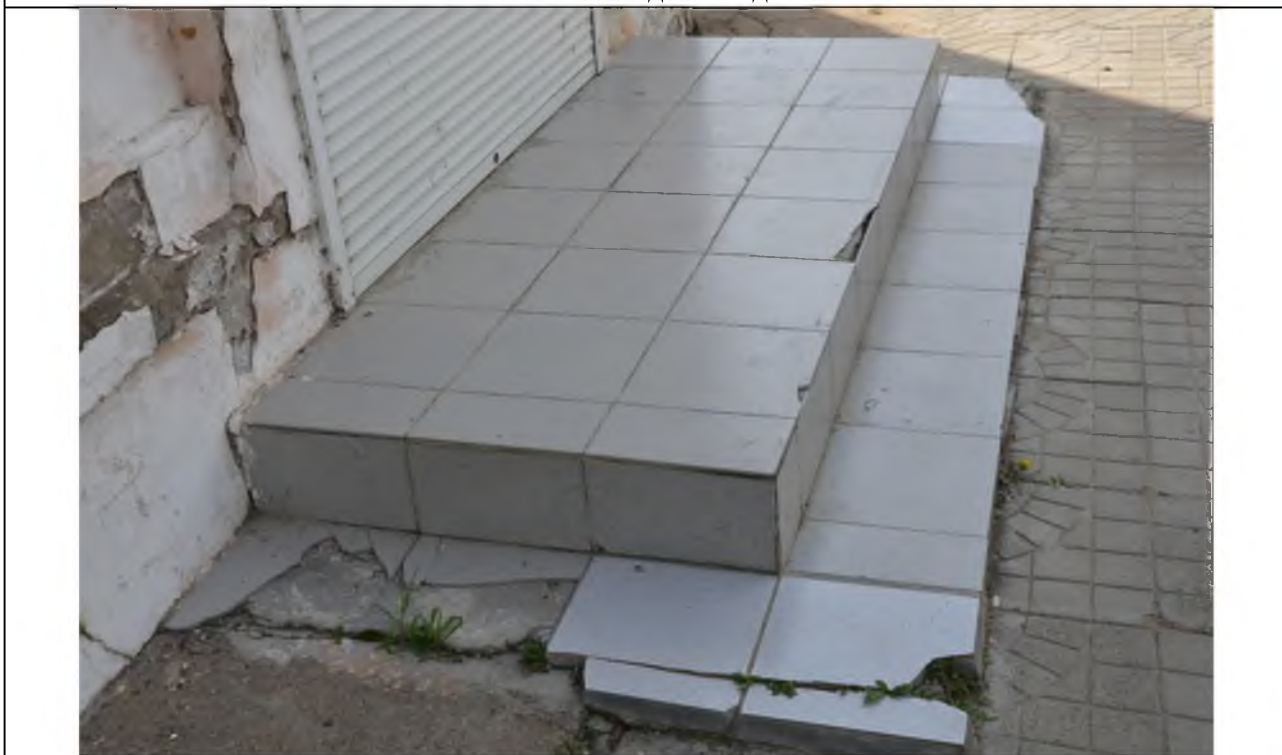
Фото 2 фрагмент фасада, состояние крыльца
