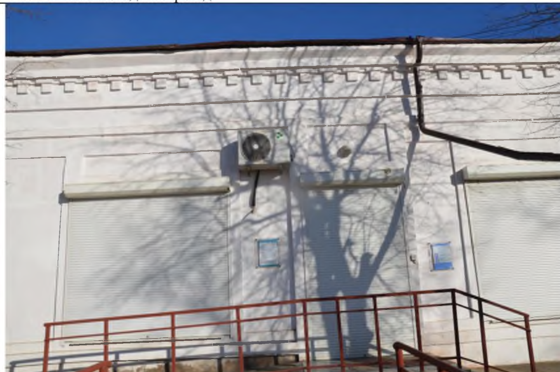
Фото 4 фрагмент юго-западного фасада, вход в помещение 1.
