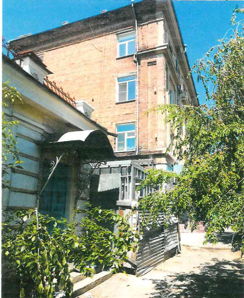
Вид с юга на ОКН и на участок строительства магазина
