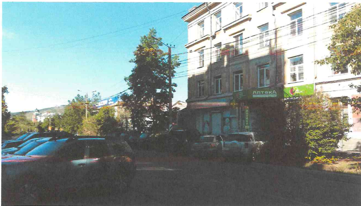
Фото 3. Дом жилой по адресу г. Чита, ул. Ленина, 111. Фасад по ул. Журавлева
