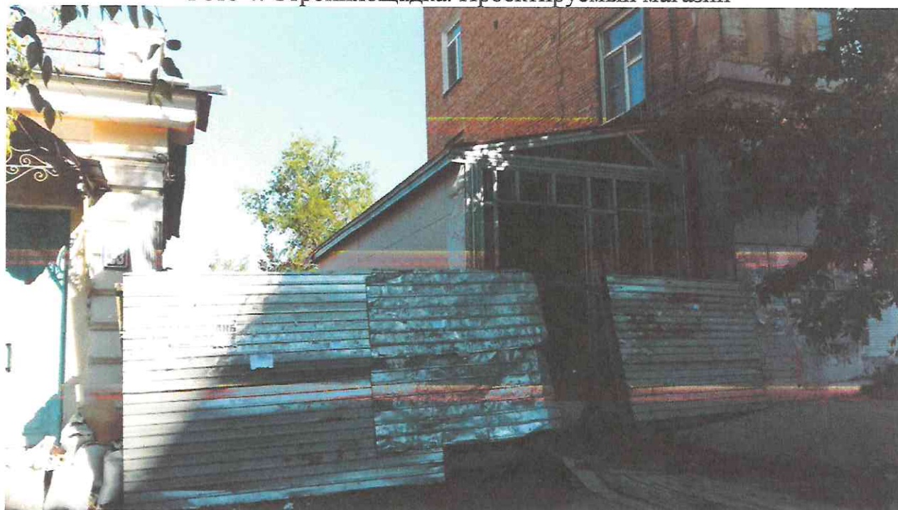
Фото 4. Стройплощадка. Проектируемый магазин
