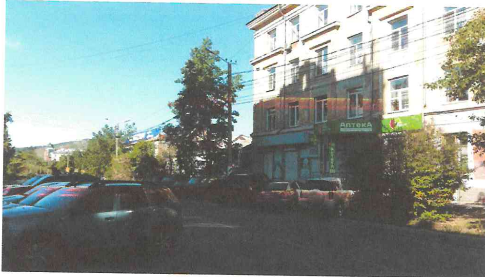
Фото 3. Жилой дом, г. Чита, ул. Ленина д.111. Современное состояние. Фасад по ул. Журавлева
