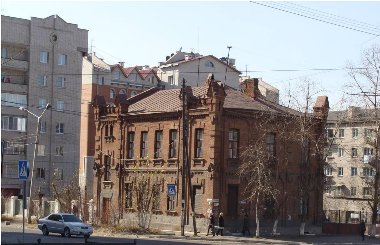
Общий вид ОКН (с востока – от перекрестка ул. Бабушкина и ул. Курнатовского)
