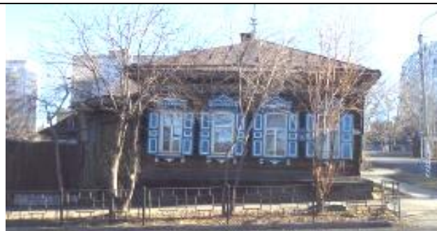
Юго-западный фасад ОКН (по ул. Чкалова)
