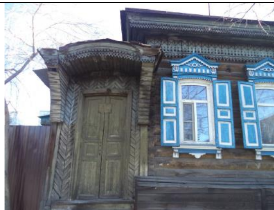
Фрагмент юго-западного фасада (с парадным входом)
