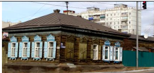
Вид ОКН с юго-юго-востока (от перекрестка ул. Чкалова и ул. Столярова)
