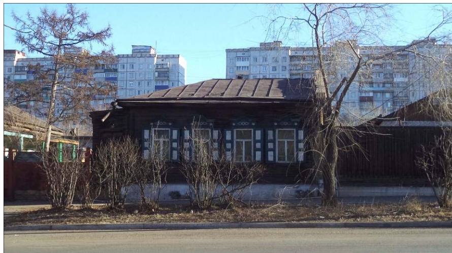
Рисунок 4. Дом жилой, ул. Чкалова, 72
