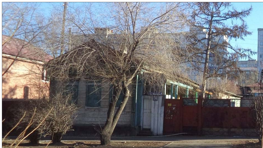
Рисунок 5. Дом жилой, ул. Чкалова, 74
