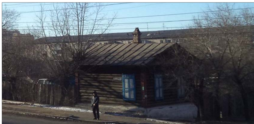
Рисунок 14. Дом жилой, ул. Н.Островского, 48
