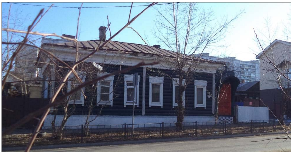
Рисунок 9. Дом жилой, ул. Чкалова, 82
