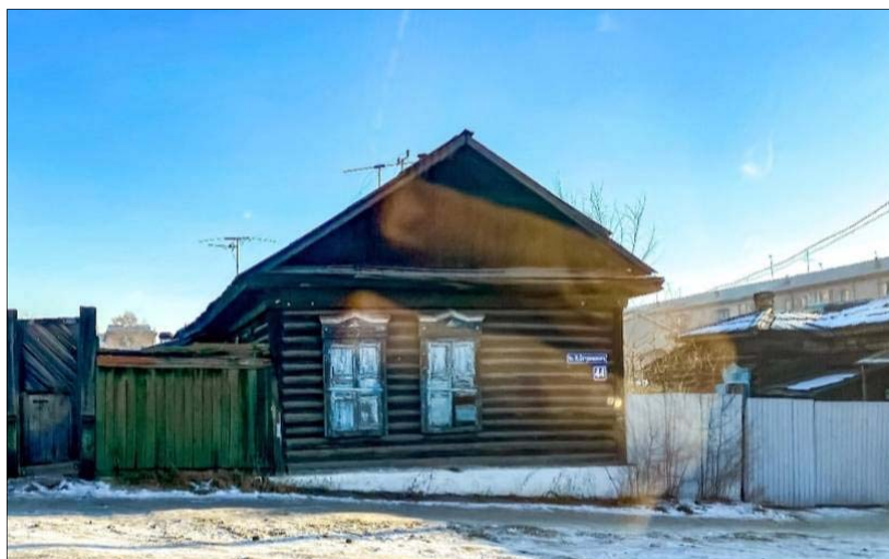
Рисунок 12. Дом жилой, ул. Н.Островского, 44
