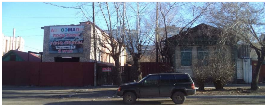
Рисунок 6. Нежилое здание, г. Чита, ул. Чкалова, 76
