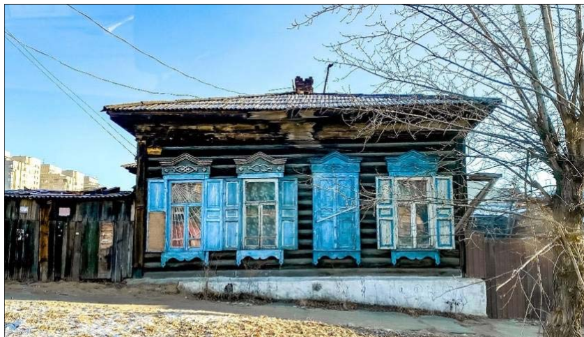
Рисунок 11. Дом жилой, ул. Н.Островского, 42
