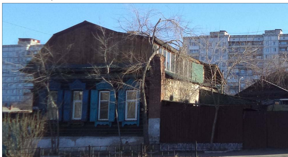
Рисунок 3. Дом жилой, ул. Чкалова, 68
