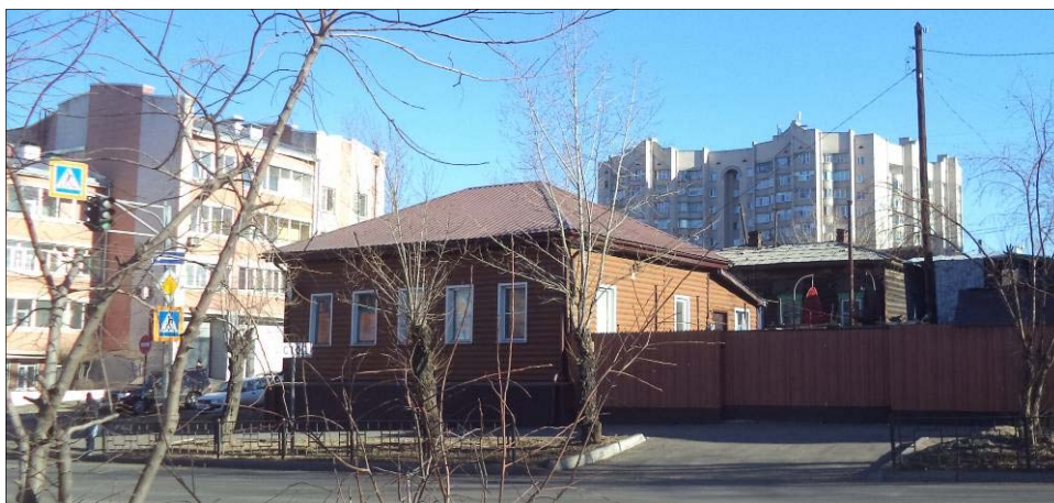
Рисунок 10. Дом жилой, ул. Чкалова, 84
