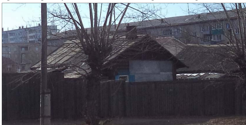
Рисунок 13. Дом жилой, ул. Н.Островского, 46
