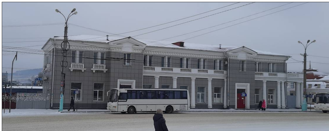
Фото 6. Административное здание, ул. Бутина, д. 4
