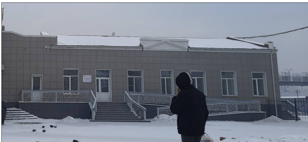
Фото 7. Административное здание, ул. Бутина, д. 4, ст. 1
