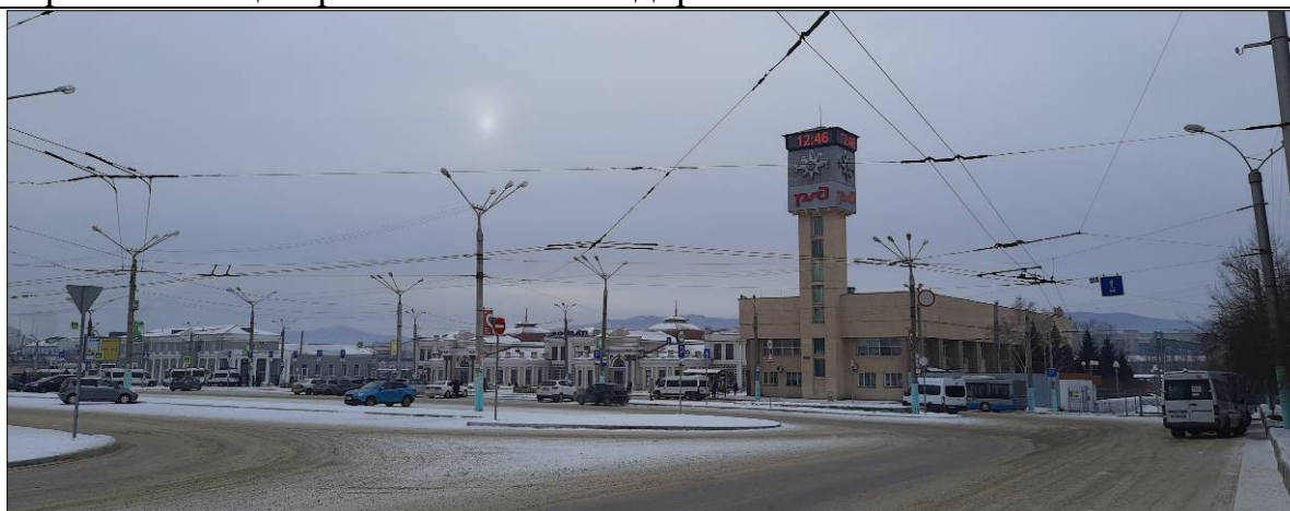
Фото 4. Вид привокзальной площади с нечетной стороны ул. Бутина от ул. Петровская. В центре ОКН «Железнодорожный вокзал»
