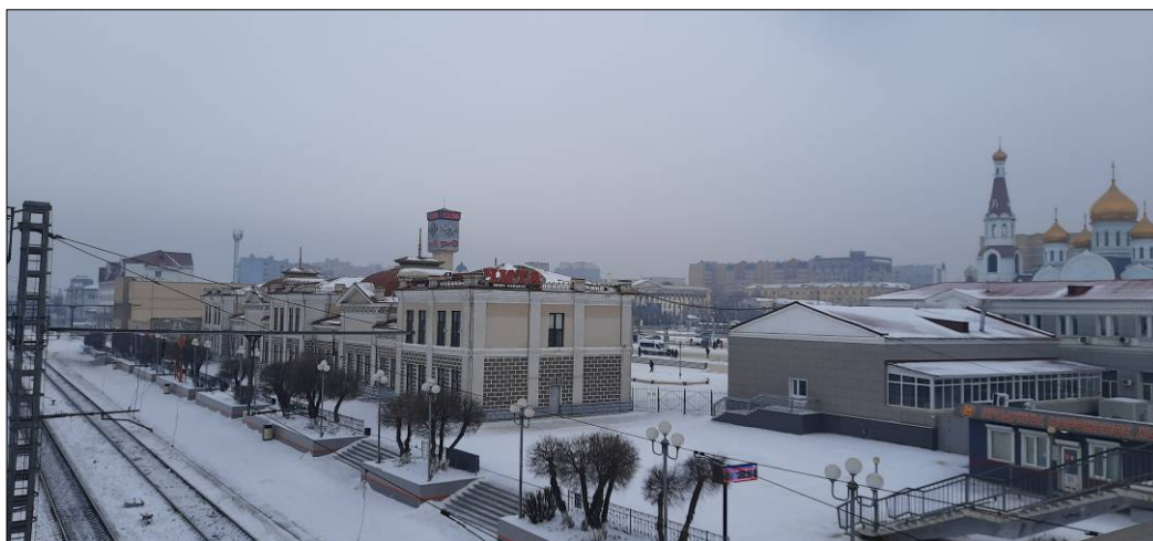
Фото 13. Вид с перехода через железную дорогу. В центре ОКН «Железнодорожный вокзал»
