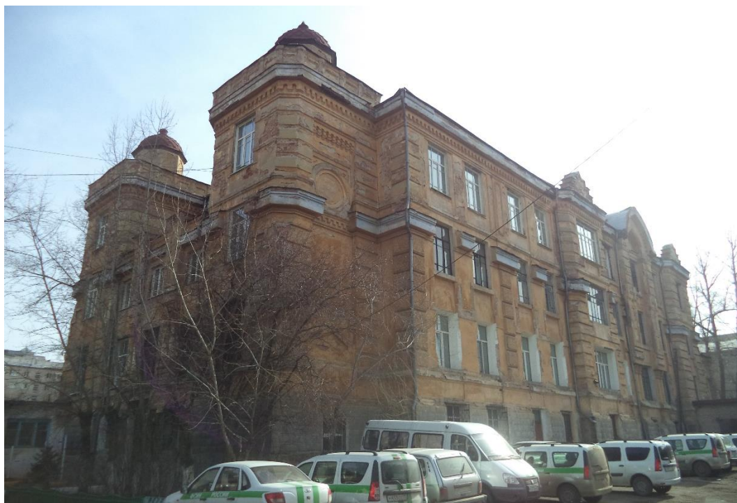
Фото. 19. Вид с дворовой части на северо-западный и юго-западный фасады
