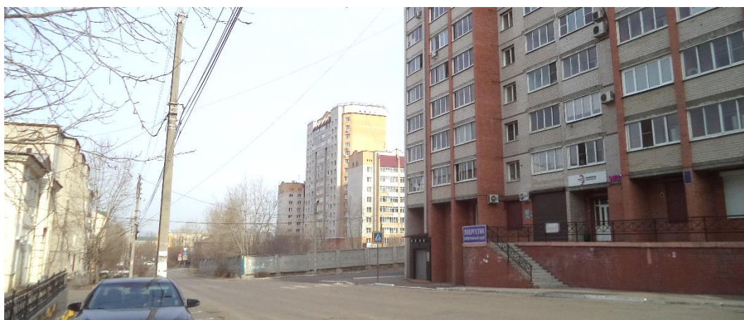
Фото. 4. Вид на запад из средней части квартала по ул. Анохина на доминанту – 16-этажный жилой дом
