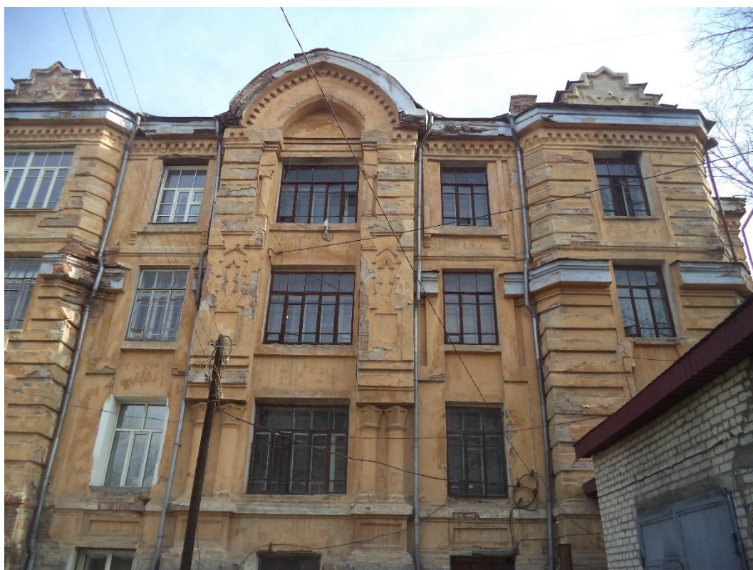
Фото. 20. Вид с дворовой части на юго-западный фасад. Справа диссонирующий объект - пристройка
