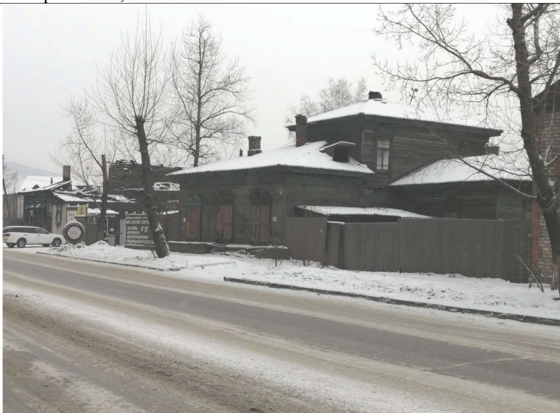
Фото 4. Вид с северо-востока на ОКН «Дом жилой Кожикова П.С.» по Красноармейской, 29
