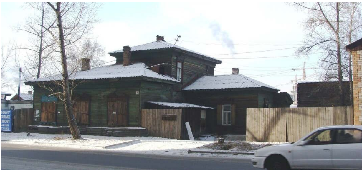
Рисунок 1. ОКН «Дом жилой Кожикова П.С.», Красноармейская, 29
