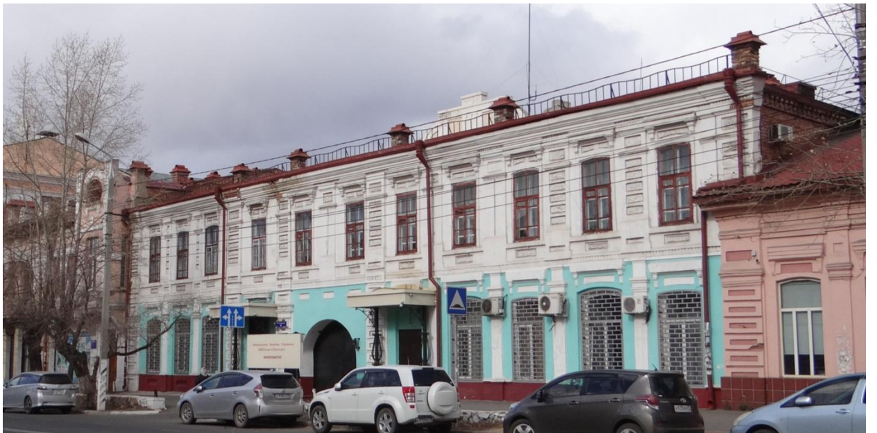
Юго-западный фасад «Дом Костина»
