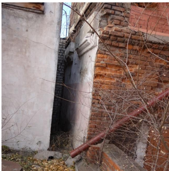
Северо-восточный фасад пристроя «Гостиница «Гранд-отель» и гараж.
