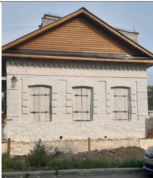
Северо- западный фасад
