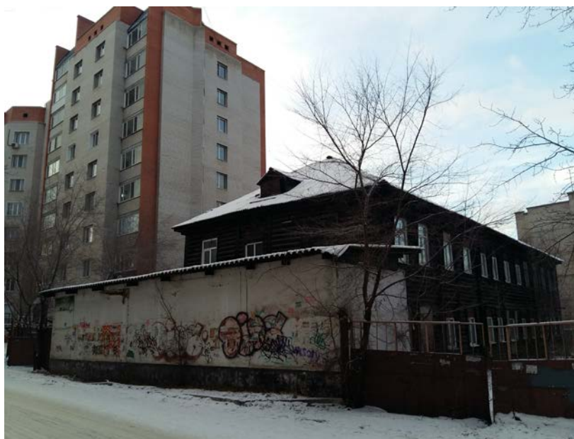
Фото 10. Нежилое здание (административное), ул. Хабаровская,5.. Дом жилой, ул. Хабаровская,1 (т.3)
