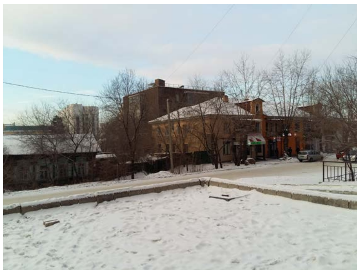
Фото 7. Дом жилой, ул. Хабаровская,9, дом жилой, ул. Бутина,30( т.4)
