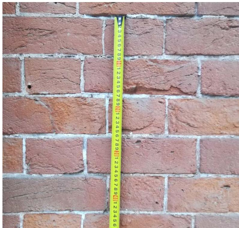
*Рис.4. Замер кирпичной кладки здания по ул. Амурской,109*
