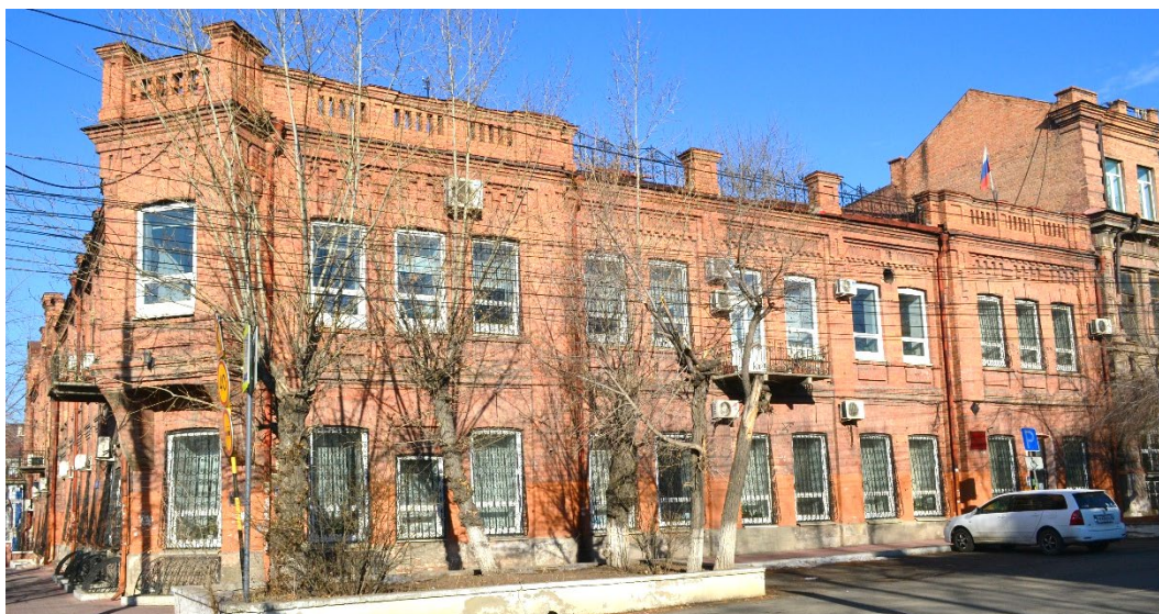
Рис. 2. Главный фасад ОКН «Дом доходный Кулаева» по ул. 9 Января
