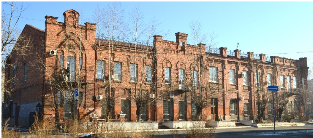
Рис. 1. Главный фасад ОКН «Дом доходный Кулаева» по ул. Анохина
