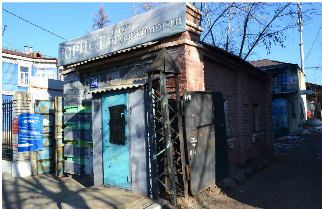
Фото. 14. Вид на здание проходной по ул. Анохина, д. 48, к. 1.
