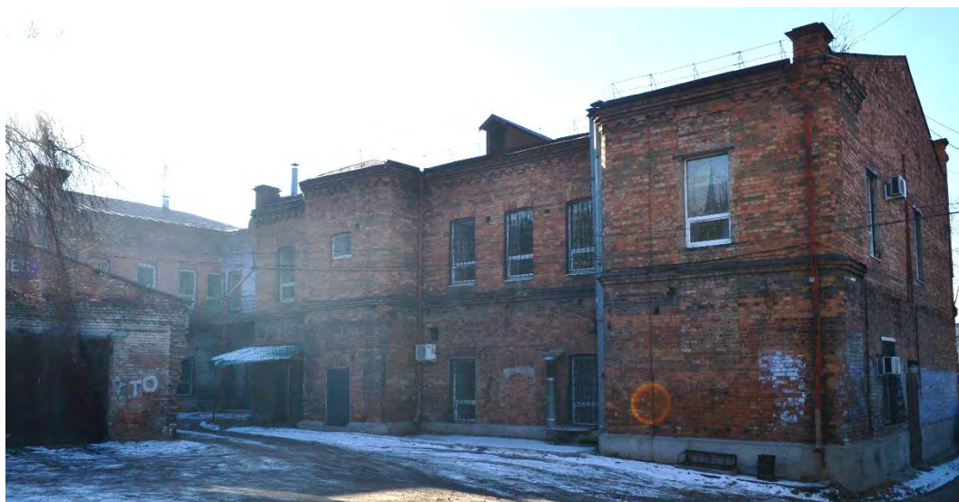
Фото. 22. Вид с дворовой части на северо-восточный фасад ОКН «Дом доходный Кулаева» с расстояния 2Н.
