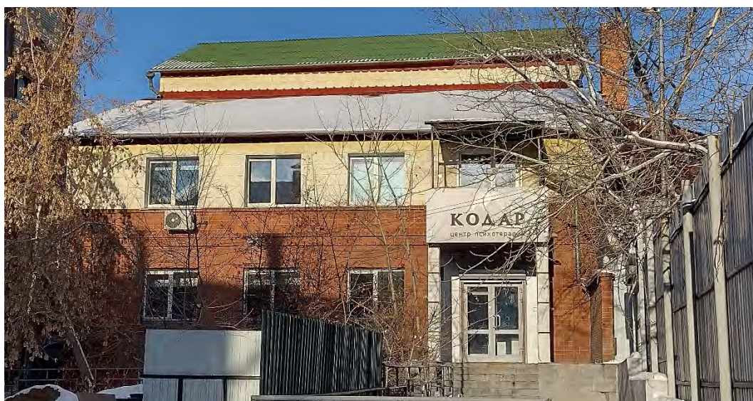
Фото. 13. Вид на административное здание по ул. Анохина, д. 52.
