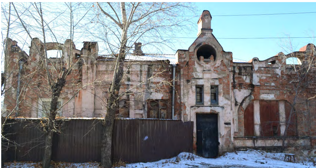
Фото. 42. Вид на главный фасад выявленного ОКН «Здание общественное».
