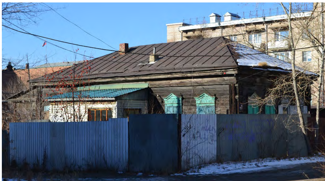
Фото. 43. Вид на ОКН «Дом жилой начало XX в.».
