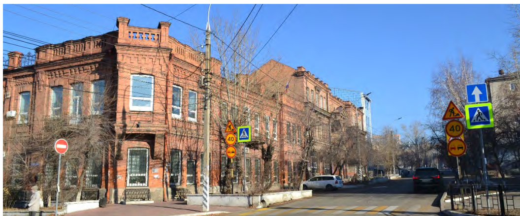
Фото. 25. Вид с южного угла квартала на север с расстояния 2Н. Слева направо: ОКН «Дом доходный Кулаева», ОКН «Дом доходный Хлыновского В.В.».
