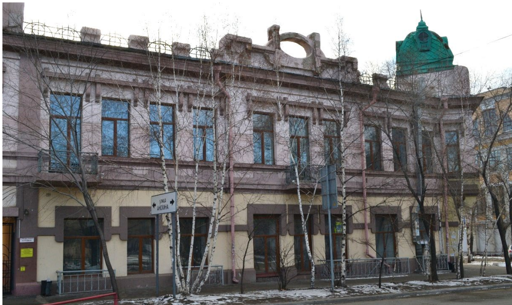
Рис. 1. Главный (северо-западный) фасад ОКН «Усадьба Зазовских. Дом Зазовских» по ул. Анохина, д. 56. Вид с ул. Полины Осипенко
