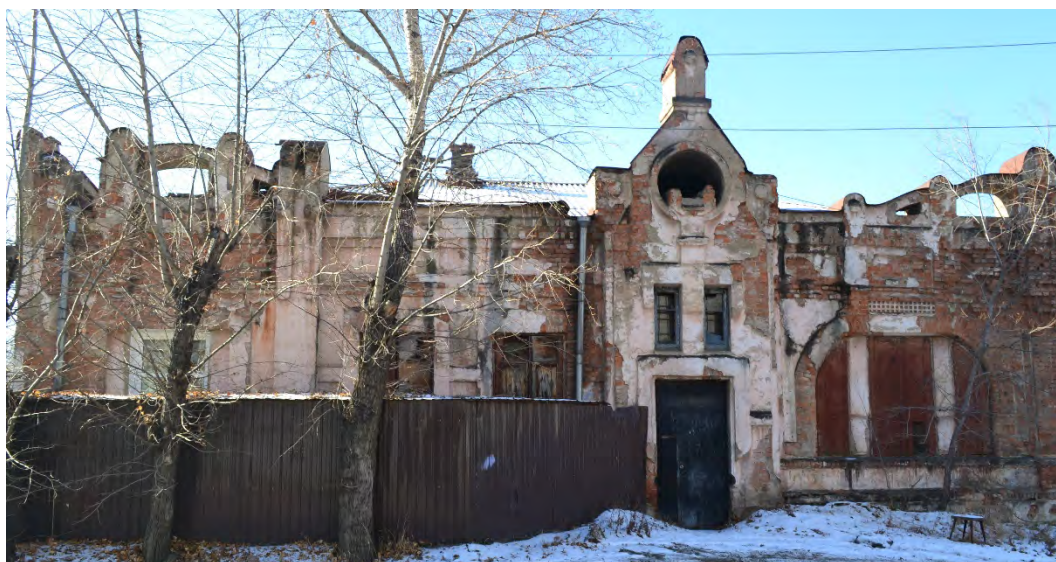
Фото. 36. Вид на главный фасад выявленного ОКН «Здание общественное».
