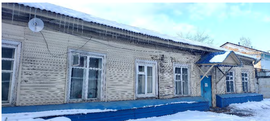
Фото. 33. Вид со двора на административное здание по ул. 9 Января, д. 356.
