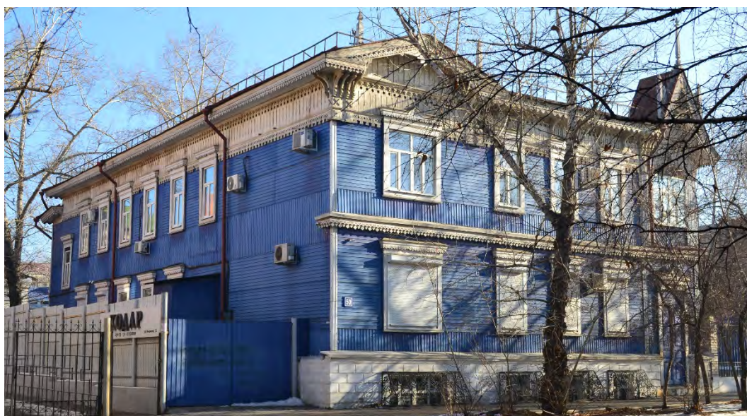
Фото. 17. Вид с середины квартала по ул. Анохина на ОКН «Дом жилой И.И. Козлова».
