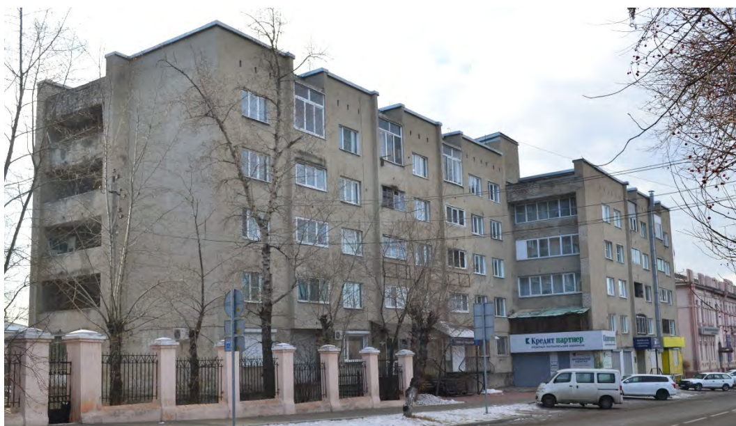
Фото. 2. Вид на 5-этажный жилой дом по ул. Полины Осипенко, д. 14.
