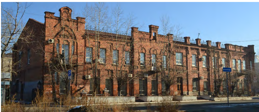
Фото. 22. Вид с противоположной стороны ул. Анохина на ОКН «Дом доходный Кулаева».
