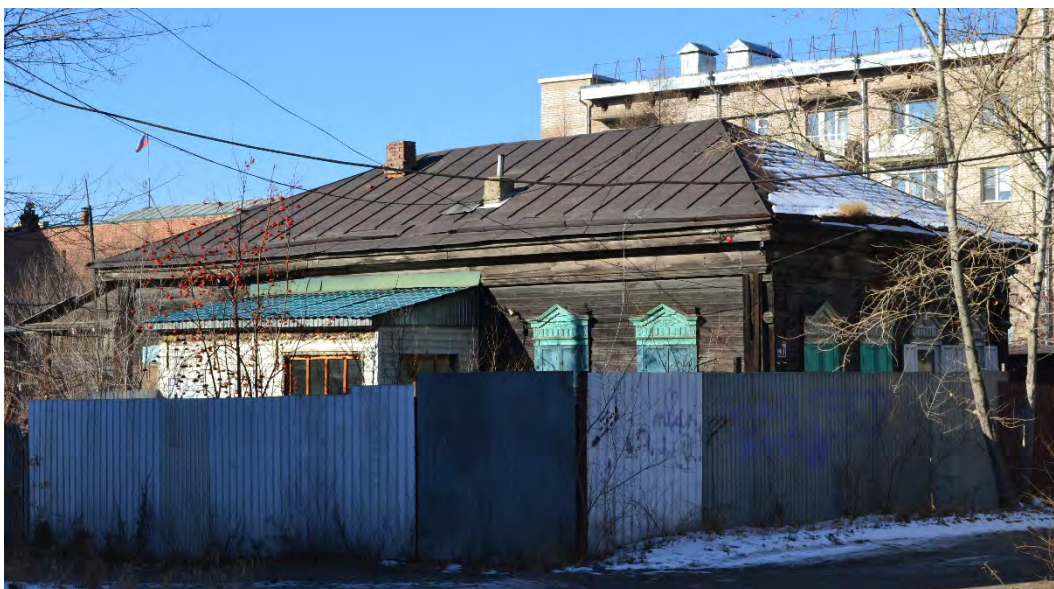
Фото. 37. Вид на ОКН «Дом жилой начало XX в.».
