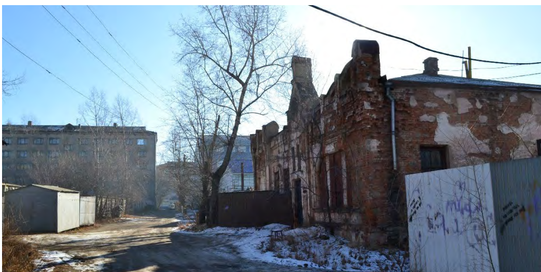
Фото. 38. Вид на восток с конца ул. Ингодинской. Справа – выявленный ОКН «Здание общественное».
