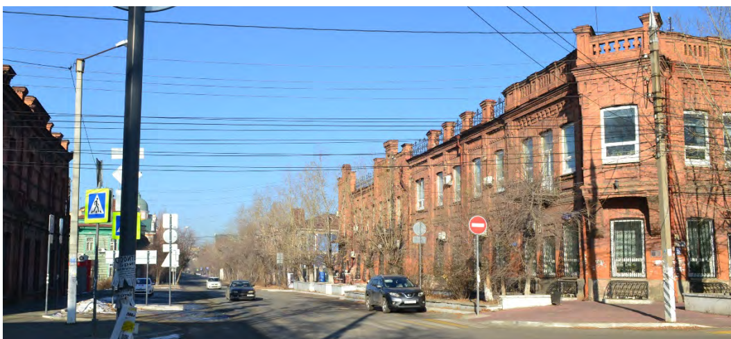
Фото. 23. Вид с южного угла квартала на запад. Справа - ОКН «Дом доходный Кулаева».
