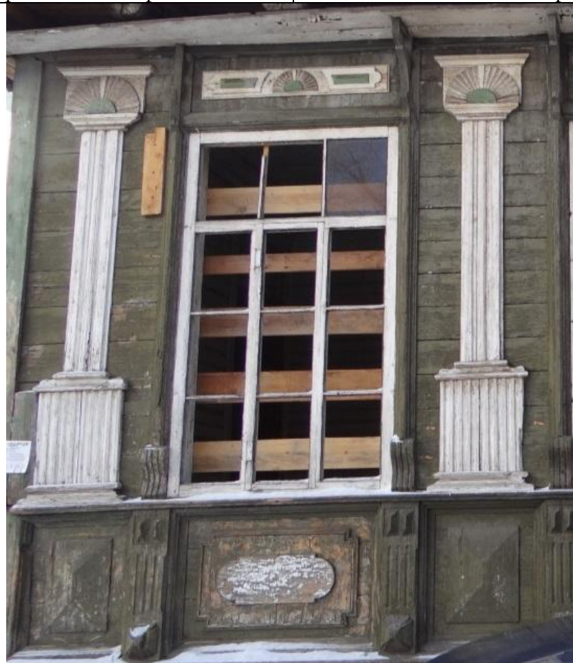
Северо-западная галерея Наличники проемов
