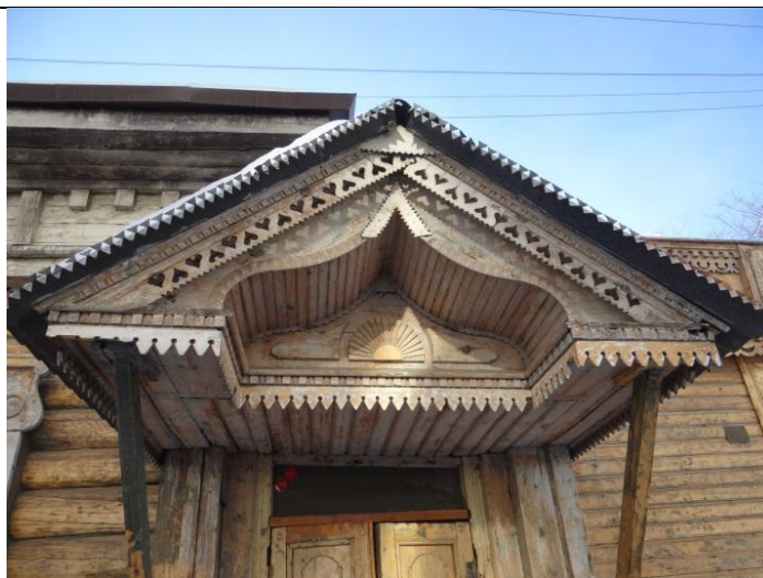
Козырек парадного входа
