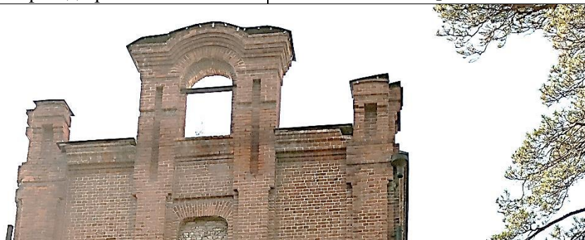
Парапетное завершение северо-восточного фасада левого объема
