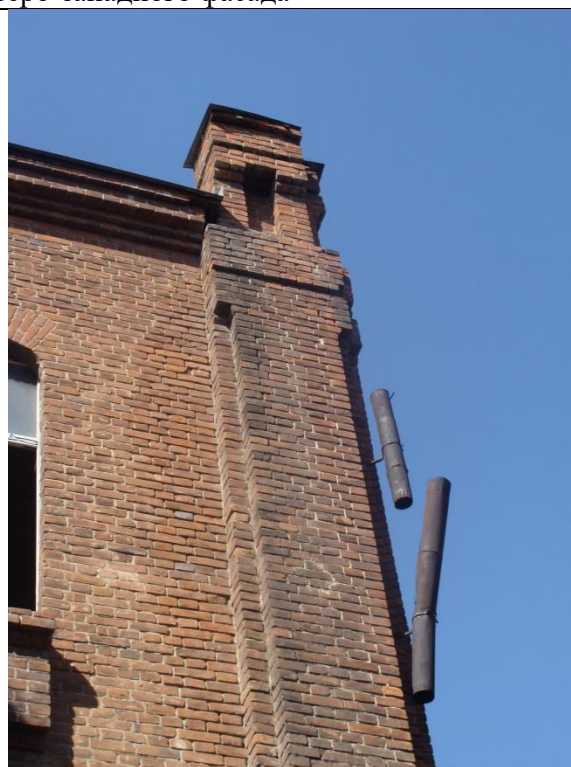
Лопатка и парапетный столбик на правом фланге юго-западного фасада
