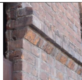
Элементы декоративной рельефной кладки фасадов
