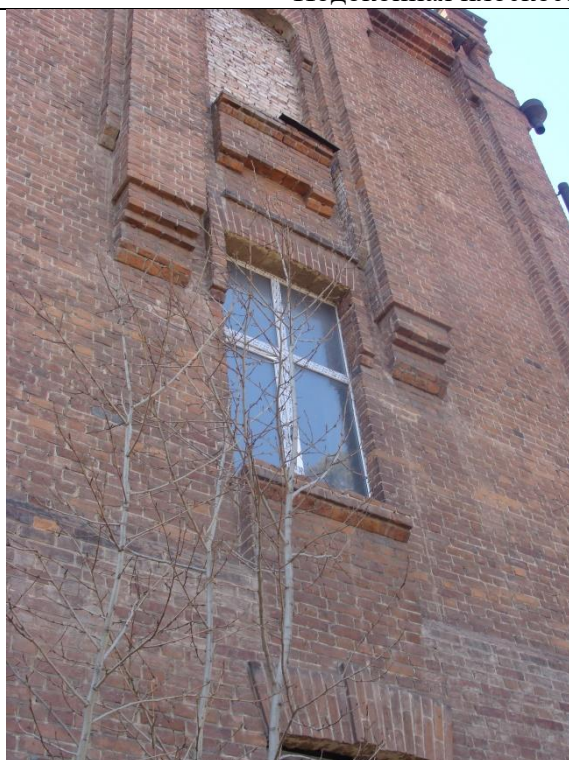
Рельефная кладка на северо-восточном фасаде левого объема
