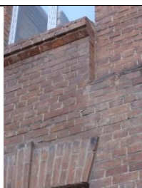
Рельефная кладка на северо-восточном фасаде левого объема
