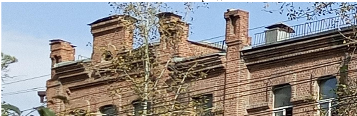
Парапетное завершение левого фланга юго-западного фасада
