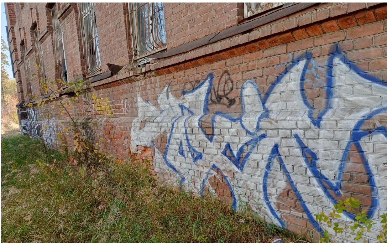
Подоконная плоскость северо-западного фасада
