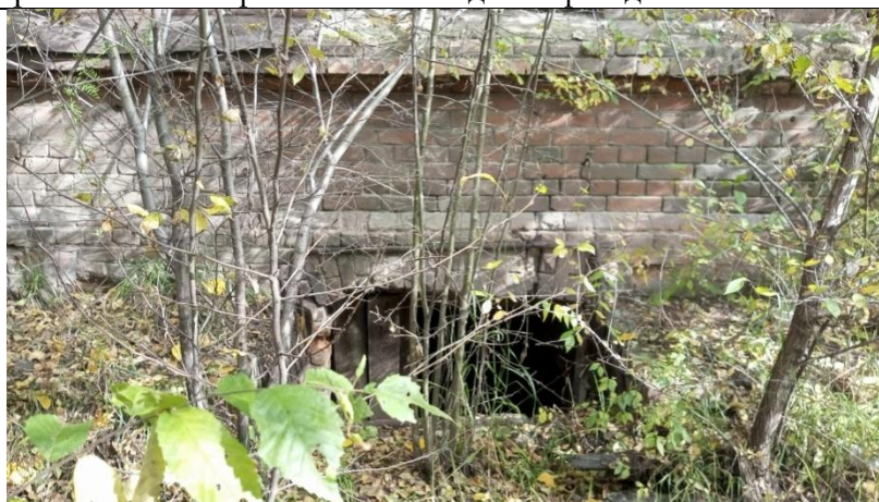
Проемы и приямки на юго-западном фасаде цоколя
