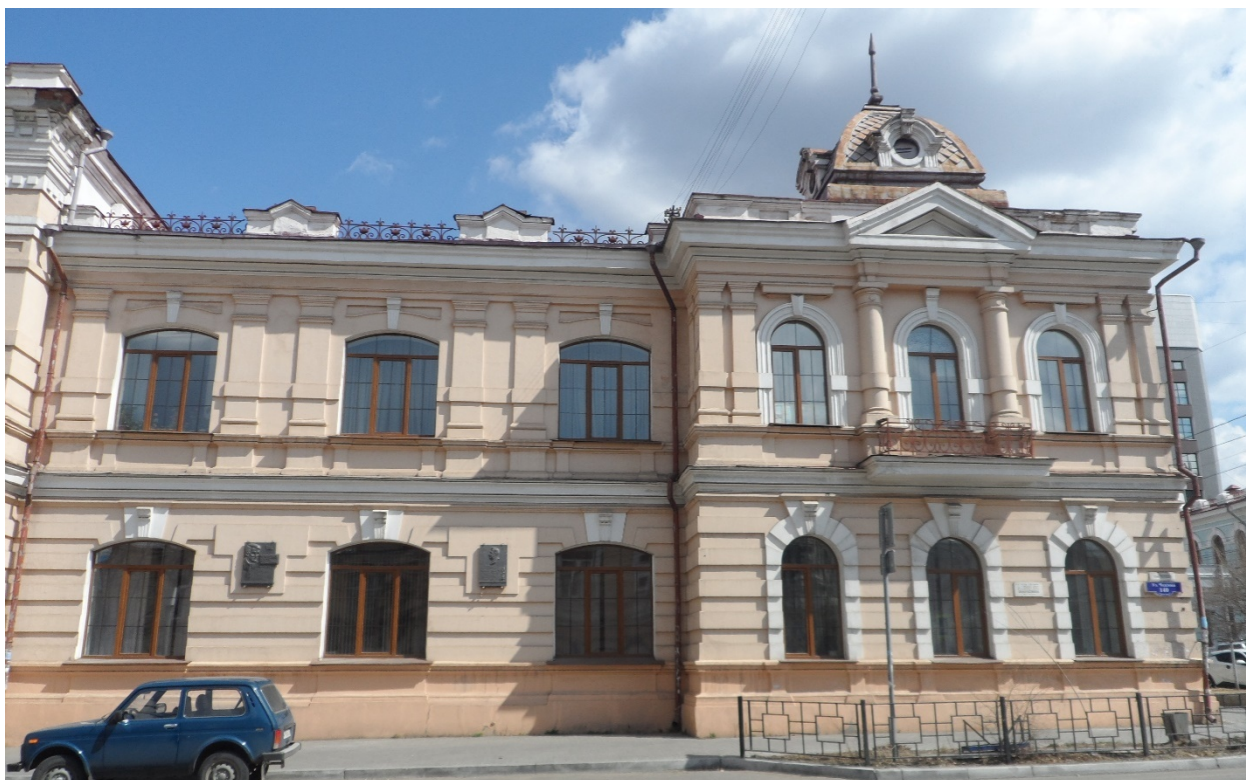
Правый фланг юго-западного фасада
