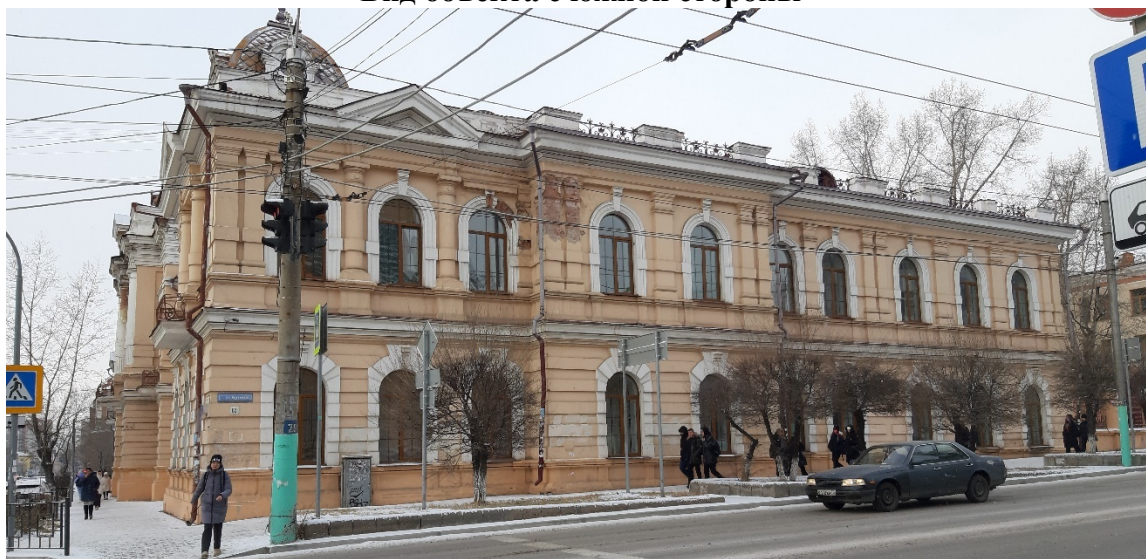
Юго-восточный фасад правого крыла
