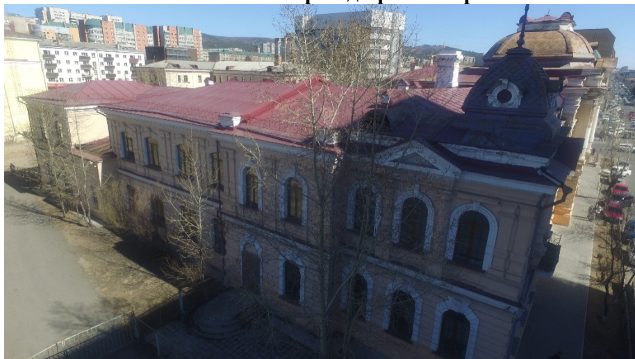
Северо-западный фасад левого крыла
