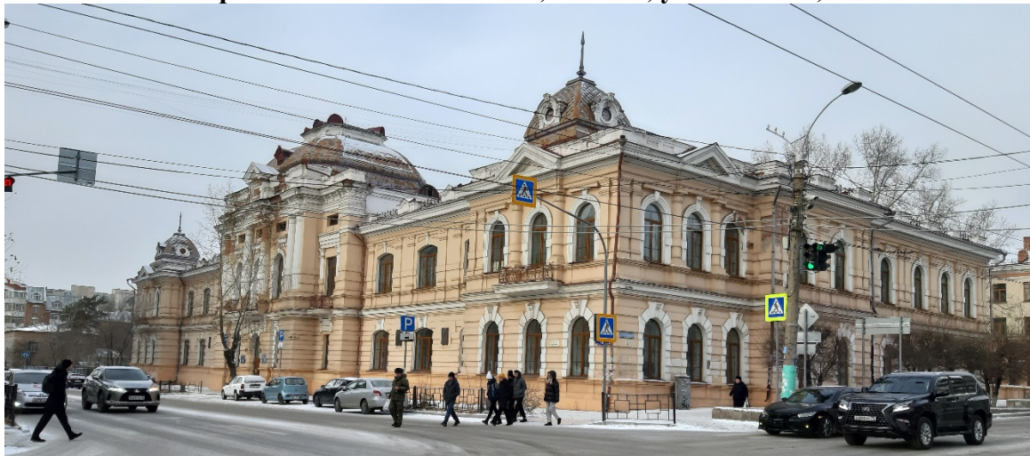
Вид объекта с южной стороны
