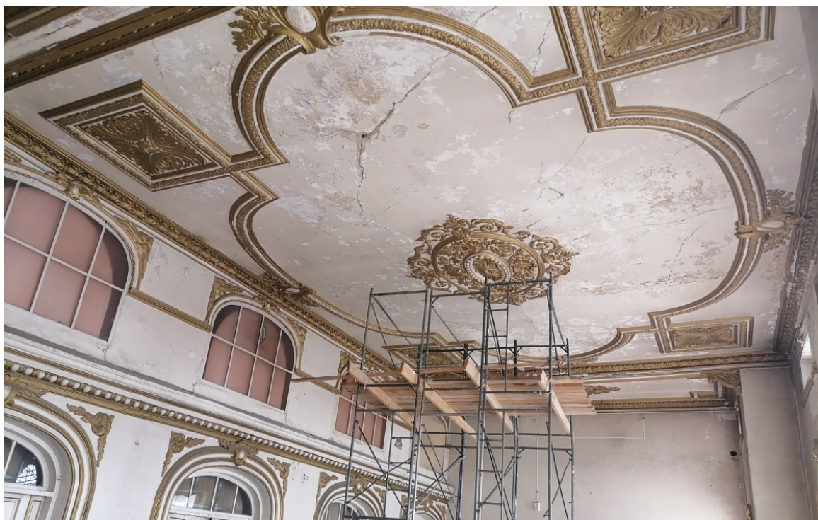
Потолок актового зала центральная часть.
