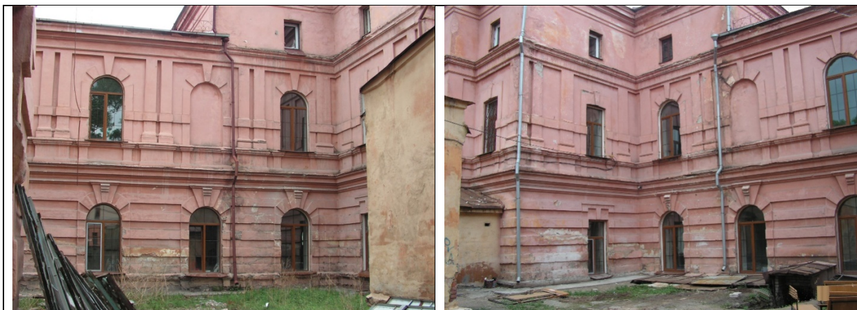
Северо-восточный фасад основного объема
