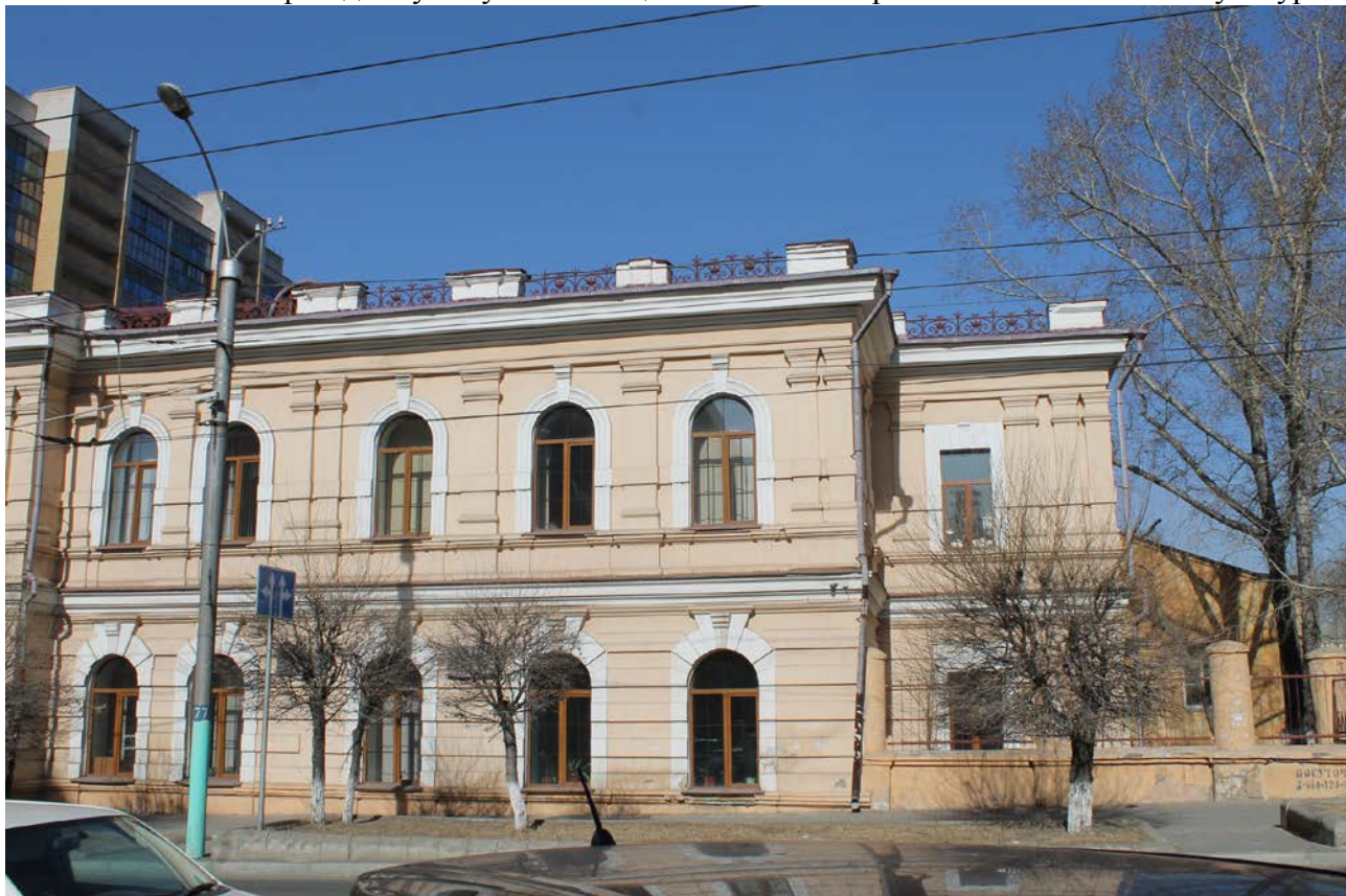
Фото 46. Торцевой фасад. Общее состояние. Загрязнение фасадов, трещины на штукатурке
