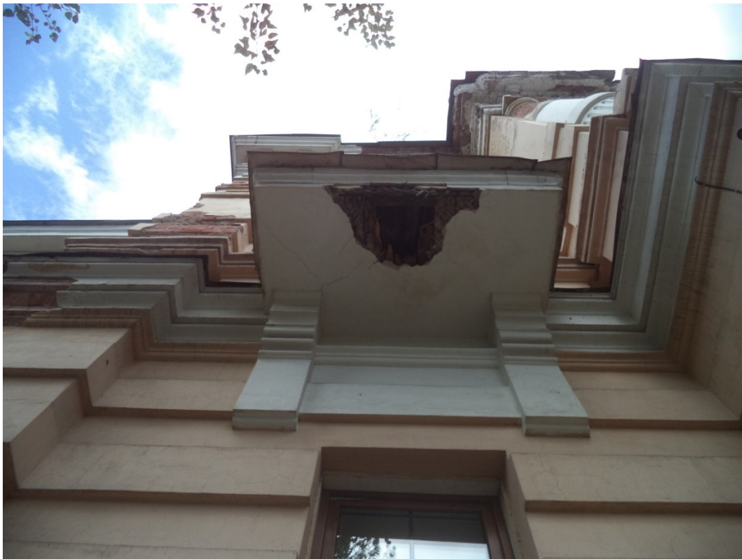
Фото 24. Главный фасад по ул. Чкалова. Центральный ризалит. Отслоение и падение штукатурки и части подшивки конструкции балкона
