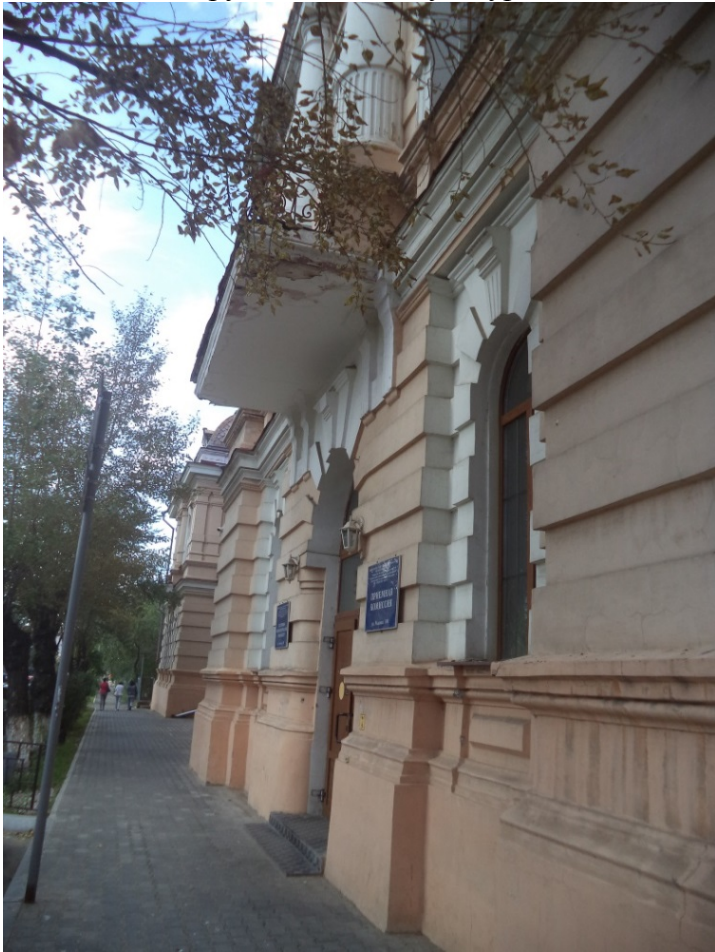
Фото 32. Главный фасад по ул. Чкалова. Центральный ризалит. Состояние карниза, фриза и низа балкона правой части ризалита.
