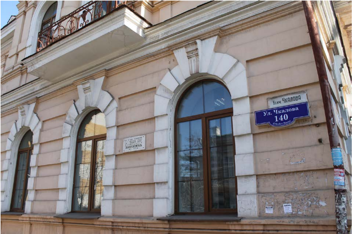
Фото 38. Главный фасад по ул. Чкалова. Правый ризалит. Балкон. Трещины на штукатурке Риск отслоения и падения фрагментов штукатурки на тротуар по краям
