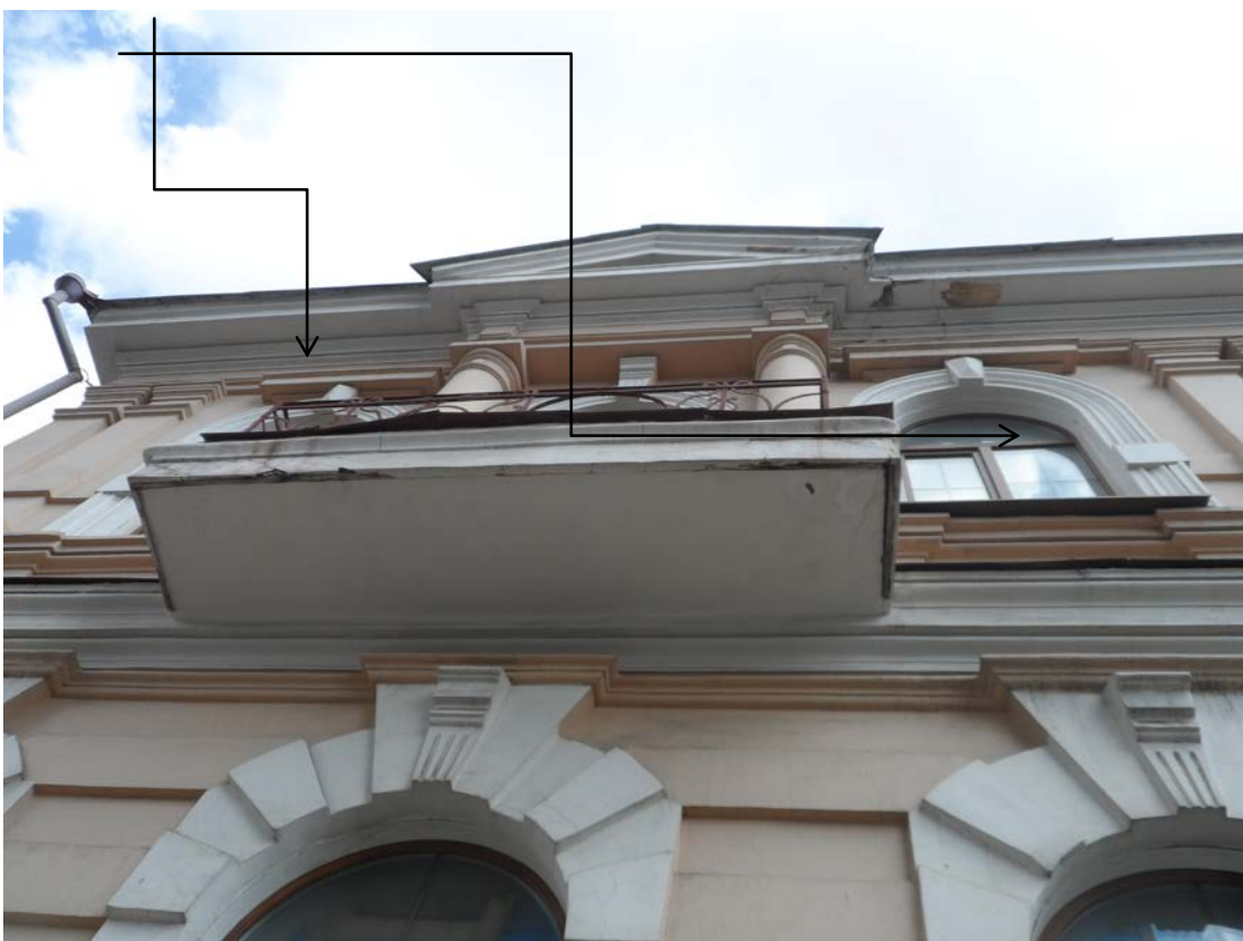
Фото 16. Главный фасад по ул. Чкалова. Левый ризалит. Трещины на штукатурке Отсутствие краски на водосточной трубе говорит о деформации стыков и протечках
