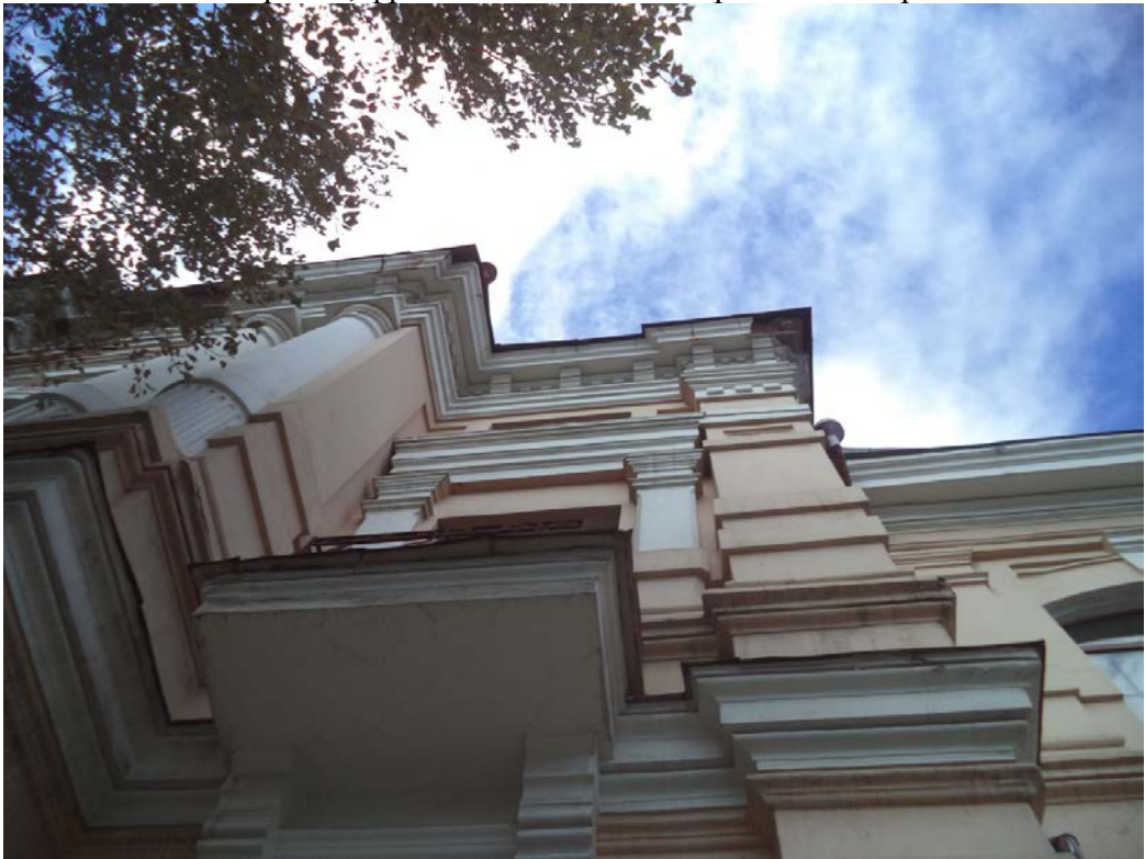
Фото 32. Главный фасад по ул. Чкалова. Центральный ризалит. Состояние карниза, фриза и низа балкона правой части ризалита.
