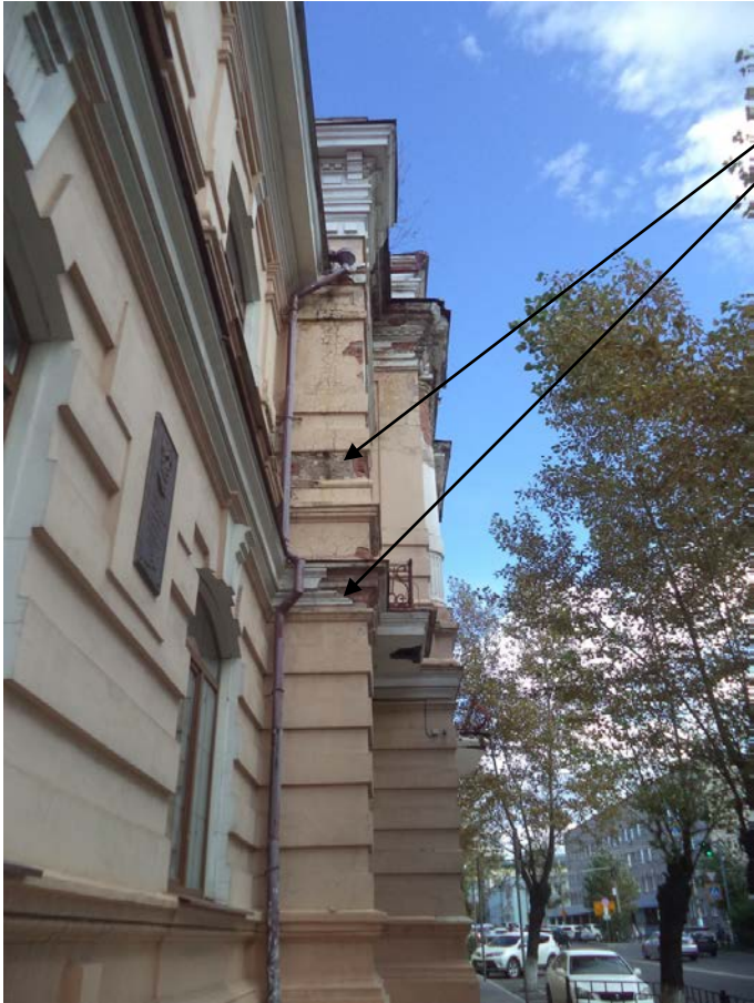
Фото 20. Главный фасад по ул. Чкалова. Центральный ризалит. Трещины на штукатурке. Загрязнения
