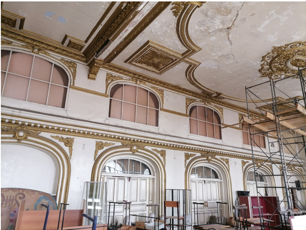
Внутренняя стена и потолок актового зала
