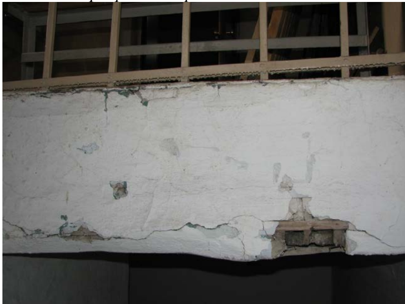
Стены и потолок здания
