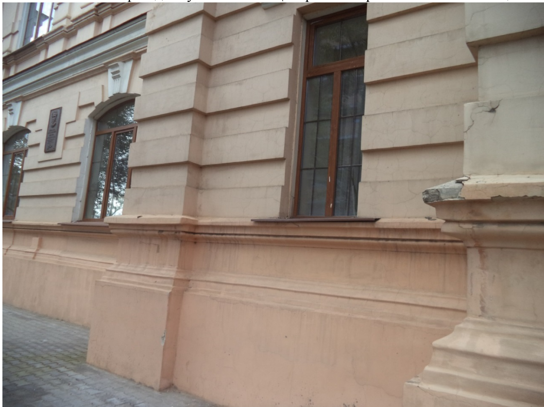
Фото 28. Главный фасад по ул. Чкалова. Центральный ризалит. Повреждение металлических отливов межэтажного пояска, загрязнения, потеки
