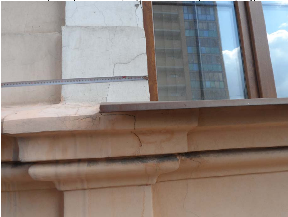
Фото 14. Главный фасад по ул. Чкалова. Левый ризалит. Загрязнение, повреждение окраски. Трещины на штукатурке. Осыпание окраски и штукатурки
