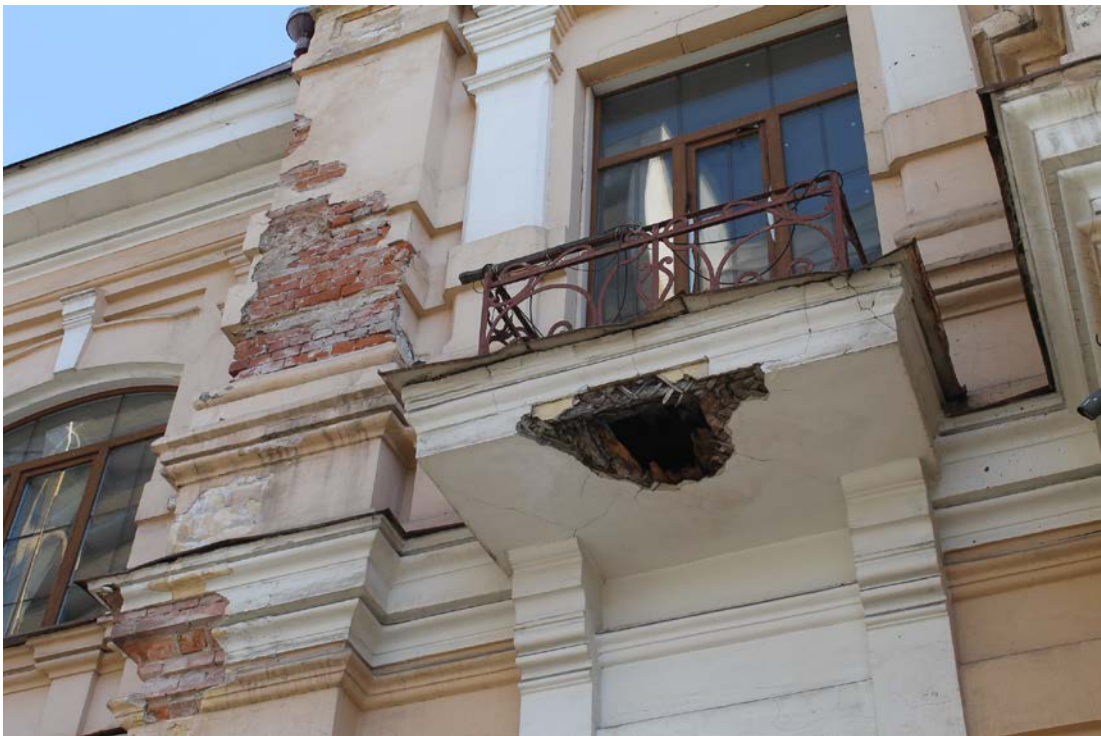
Фото 24. Главный фасад по ул. Чкалова. Центральный ризалит. Отслоение и падение штукатурки и части подшивки конструкции балкона
