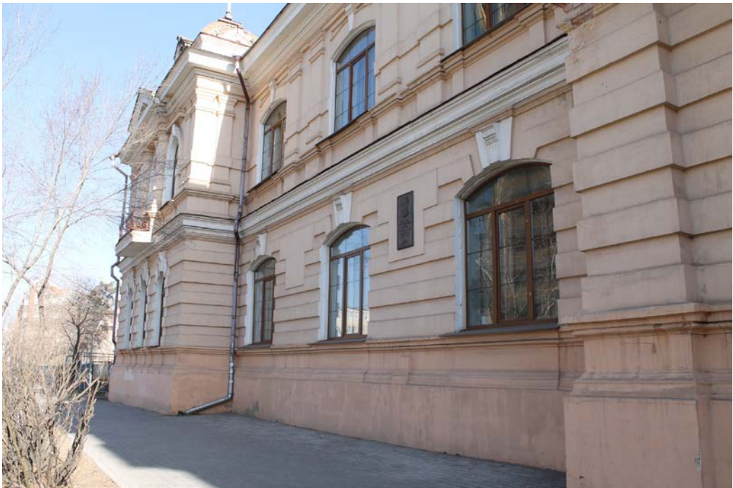
Фото 34. Главный фасад по ул. Чкалова. Левое крыло. Цоколь. Загрязнения. Трещины.
