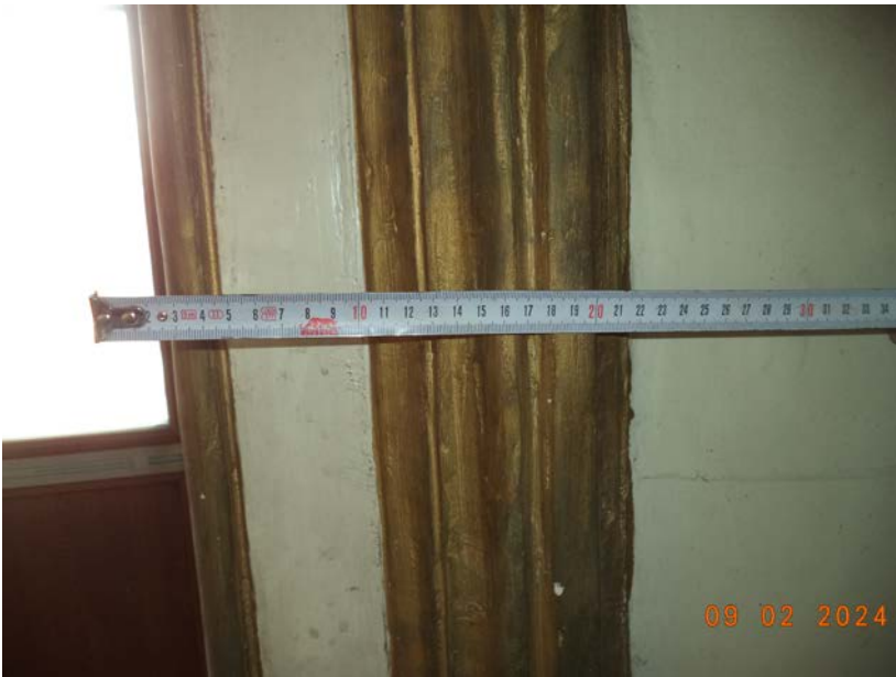
Деталь обрамления оконного проема
