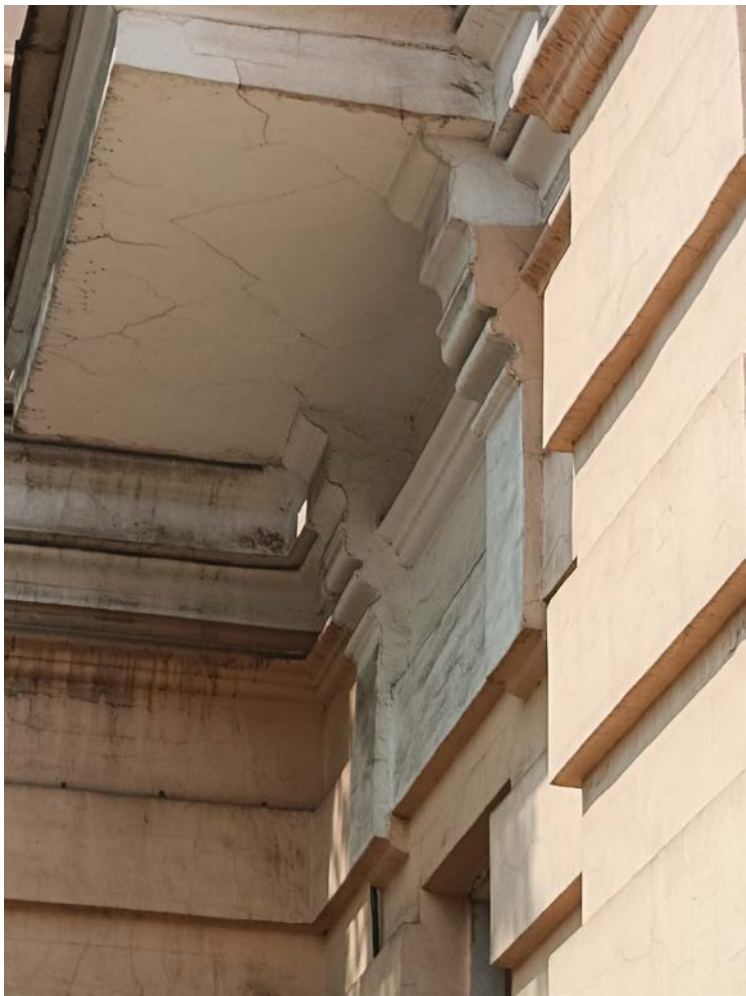
Фото 34. Главный фасад по ул. Чкалова. Левое крыло. Цоколь. Загрязнения. Трещины.
