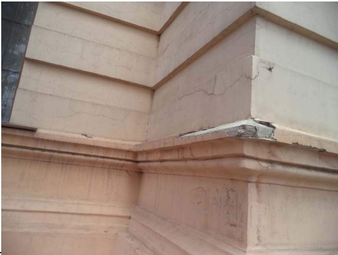
Фото 26. Главный фасад по ул. Чкалова. Центральный ризалит. Отслоение штукатурки фасадов с участков цокольного пояса. Трещины
