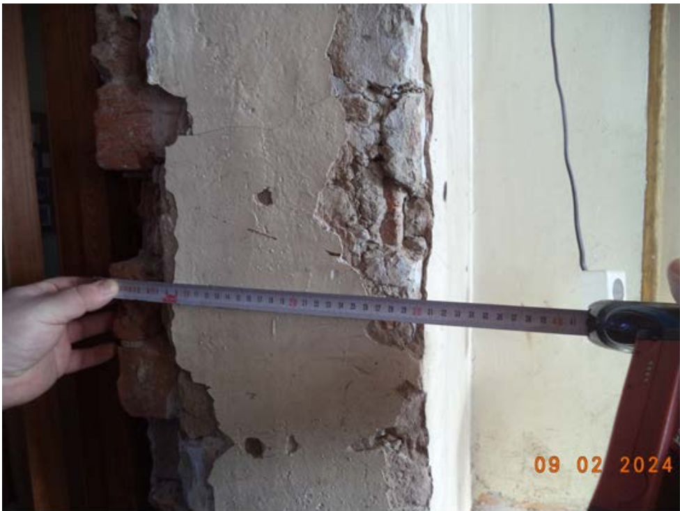
Пример состояния штукатурного и окрасочного слоя
