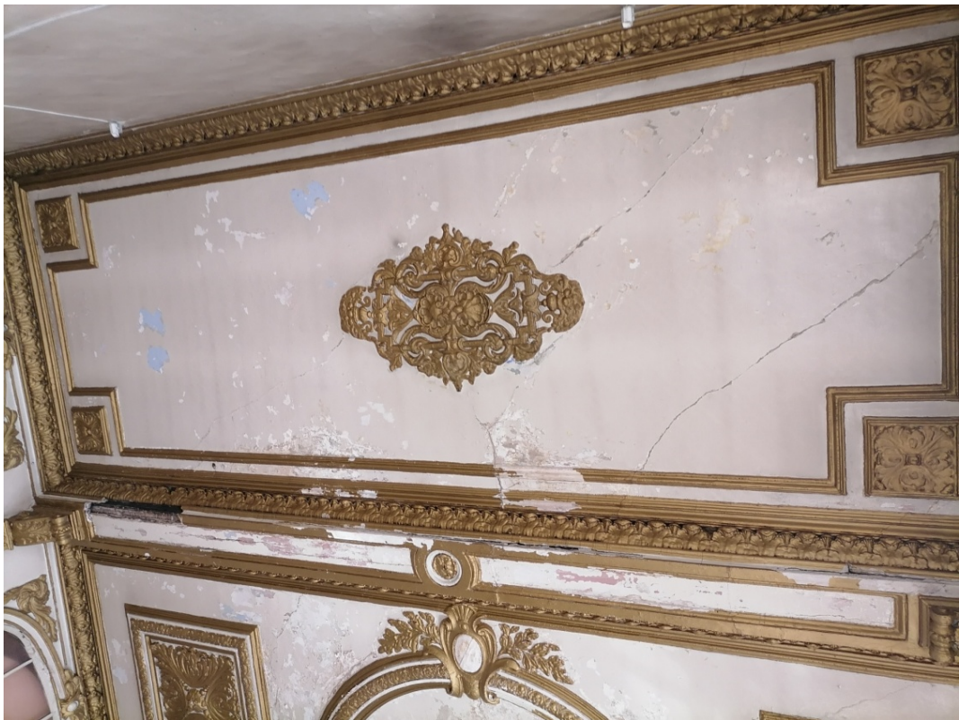
Внутренняя стена и потолок актового зала
