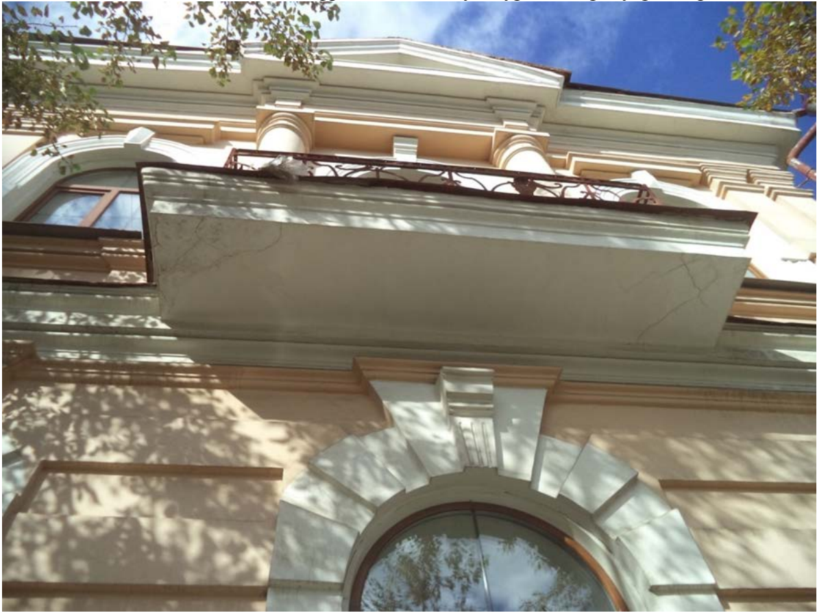
Фото 38. Главный фасад по ул. Чкалова. Правый ризалит. Балкон. Трещины на штукатурке Риск отслоения и падения фрагментов штукатурки на тротуар по краям
