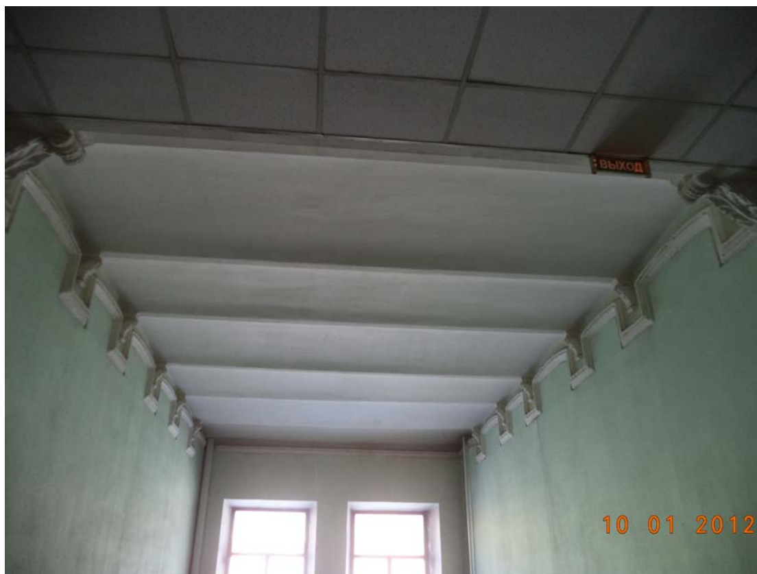
Перекрытие – кирпичные своды по металлическим оштукатуренным балкам над парадной лестницей с кронштейнами с растительным орнаментом
