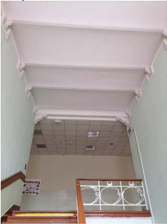
Верхняя площадка главной лестницы
