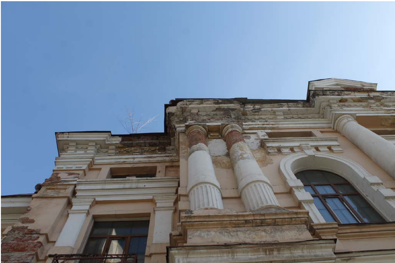
Фото 26. Главный фасад по ул. Чкалова. Центральный ризалит. Отслоение штукатурки фасадов с участков цокольного пояса. Трещины
