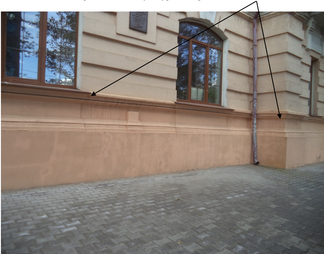
Фото 20. Главный фасад по ул. Чкалова. Центральный ризалит. Трещины на штукатурке. Загрязнения
