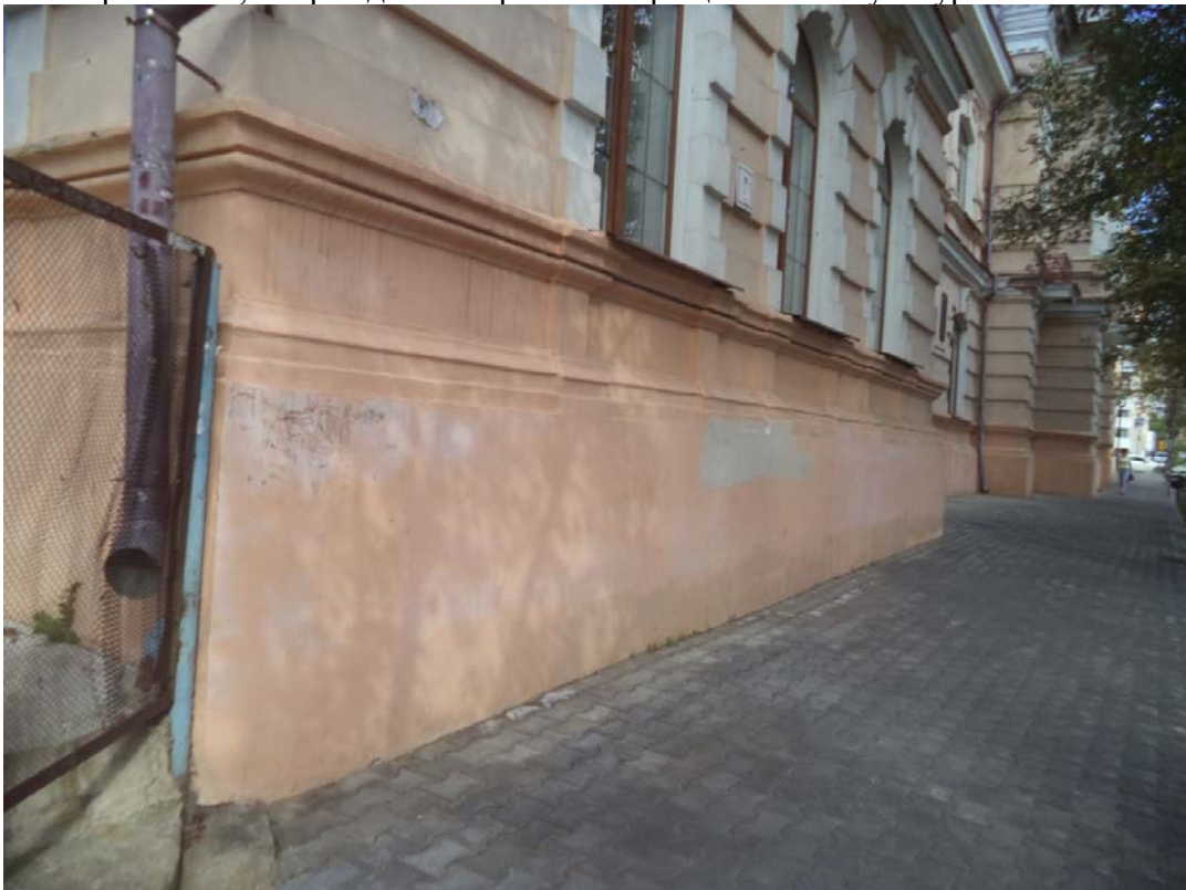
Фото 14. Главный фасад по ул. Чкалова. Левый ризалит. Загрязнение, повреждение окраски. Трещины на штукатурке. Осыпание окраски и штукатурки
