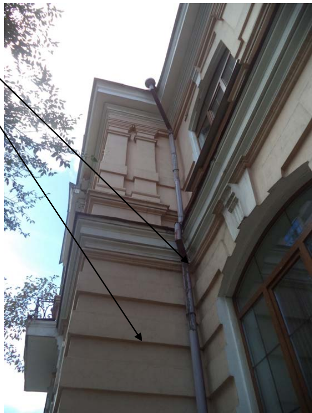
Фото 16. Главный фасад по ул. Чкалова. Левый ризалит. Трещины на штукатурке Отсутствие краски на водосточной трубе говорит о деформации стыков и протечках
