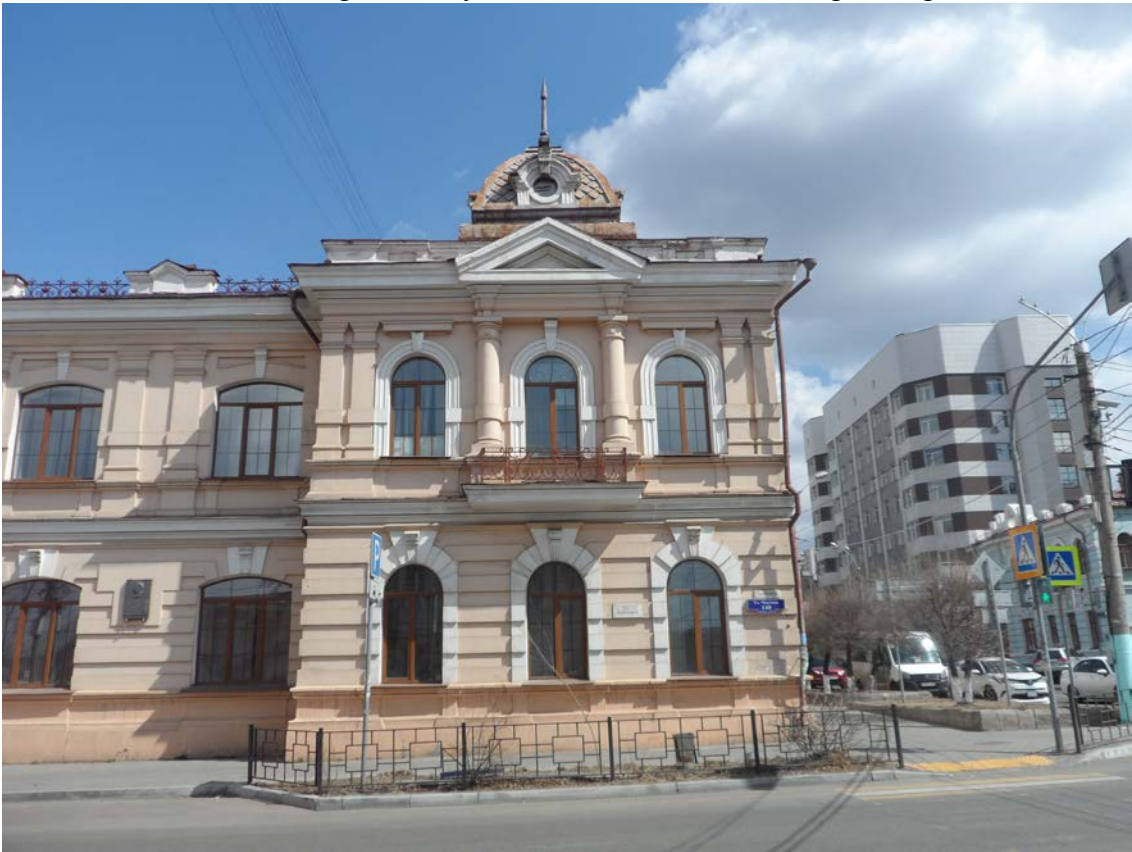
Фото 7. Главный фасад по ул. Чкалова. Общий вид. Правый ризалит.
