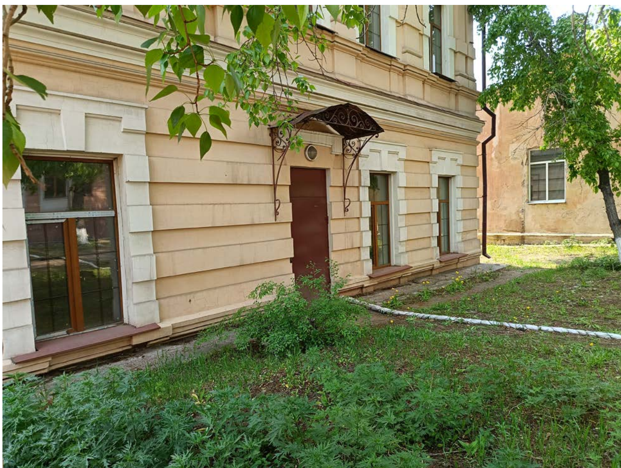
Фото 46. Торцевой фасад. Общее состояние. Загрязнение фасадов, трещины на штукатурке
