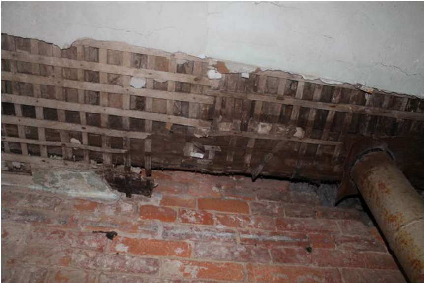
Состояние угла здания у наружной стены из-за попадания влаги (дворовой фасад центральной части)
