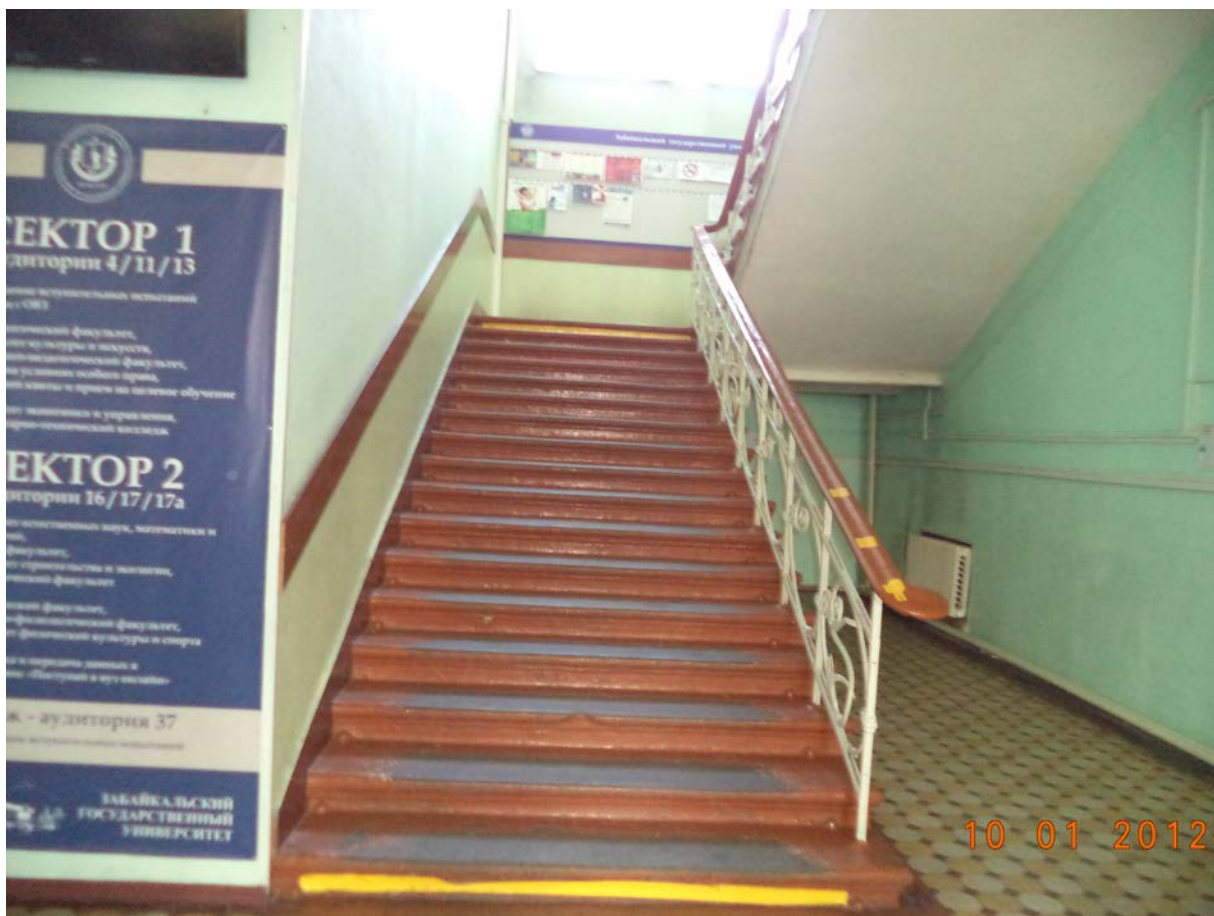
Парадная лестница. Вид из вестибюля
