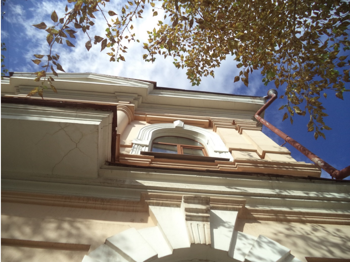
Фото 40 Главный фасад по ул. Бутина. Трещины на штукатурке Риск отслоения и падения фрагментов штукатурки на тротуар
