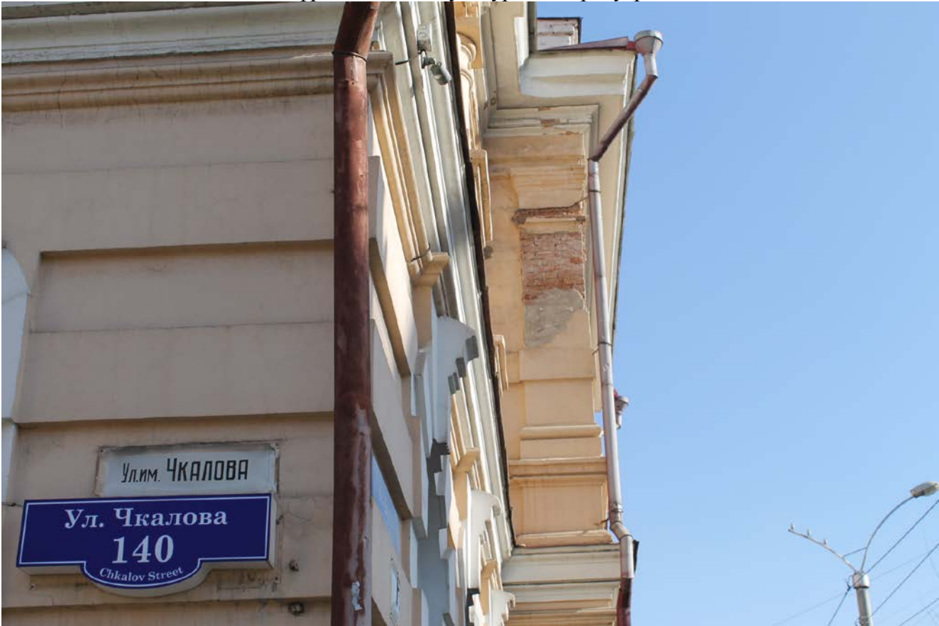
Фото 40 Главный фасад по ул. Бутина. Трещины на штукатурке Риск отслоения и падения фрагментов штукатурки на тротуар
