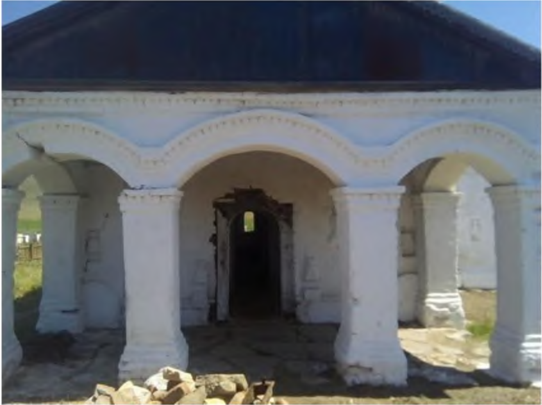
Фото 3 Вид с запада.
