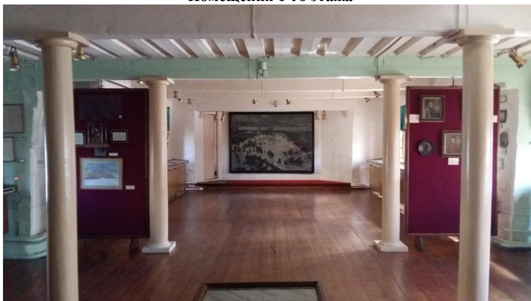
Стены и перекрытие 1-го этажа
