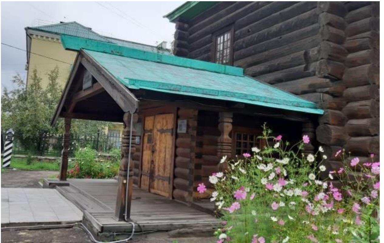
Перерубы южного фасада
