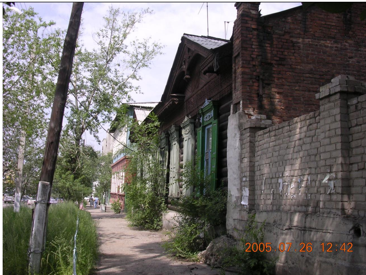
Фото 11 (Точка 9). Вид на юго-западный фасад ОКН «Дом жилой Шмуйловича Л.Х.» с юго-восточной стороны 2005 г.
