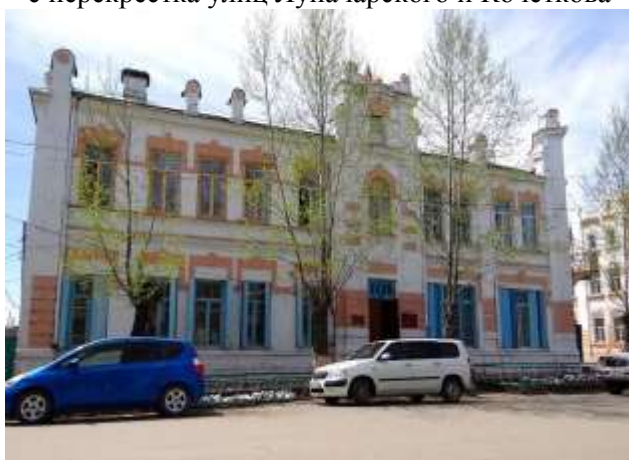
Главный С-В фасад, вид со стороны ул. Кочеткова
