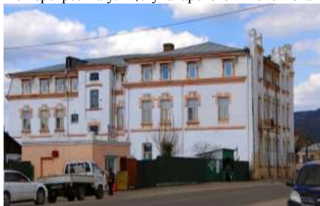
Общий вид с юга, с ул. Луначарского
