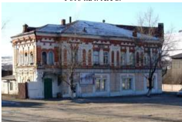
Общий вид с ул. Кочеткова, с севера
