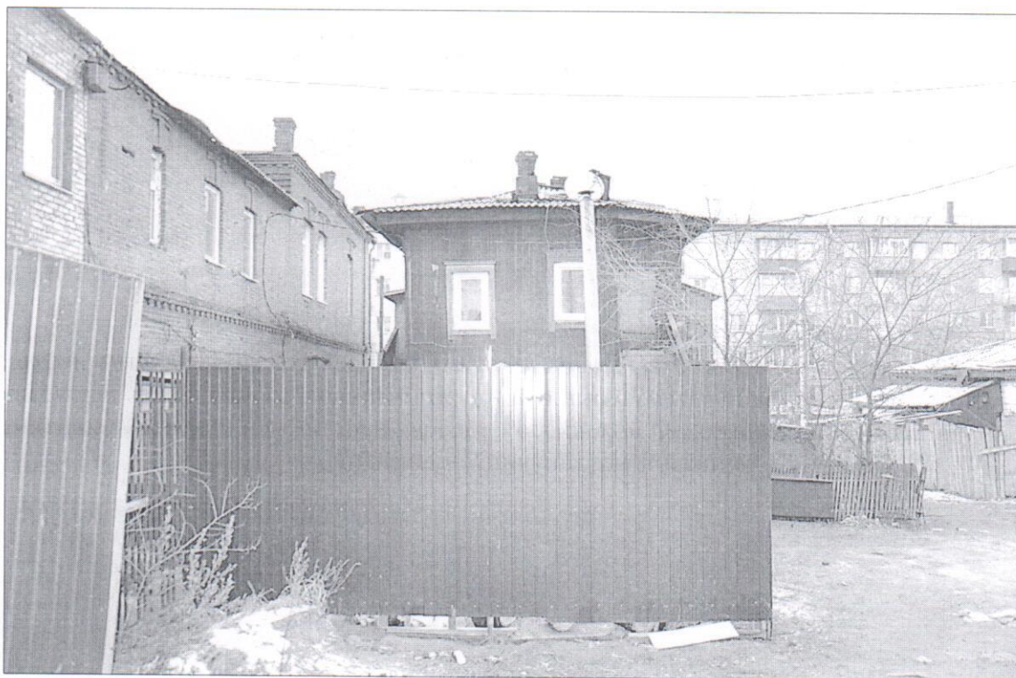
Фото 3 вид на северо-восточный фасад.
