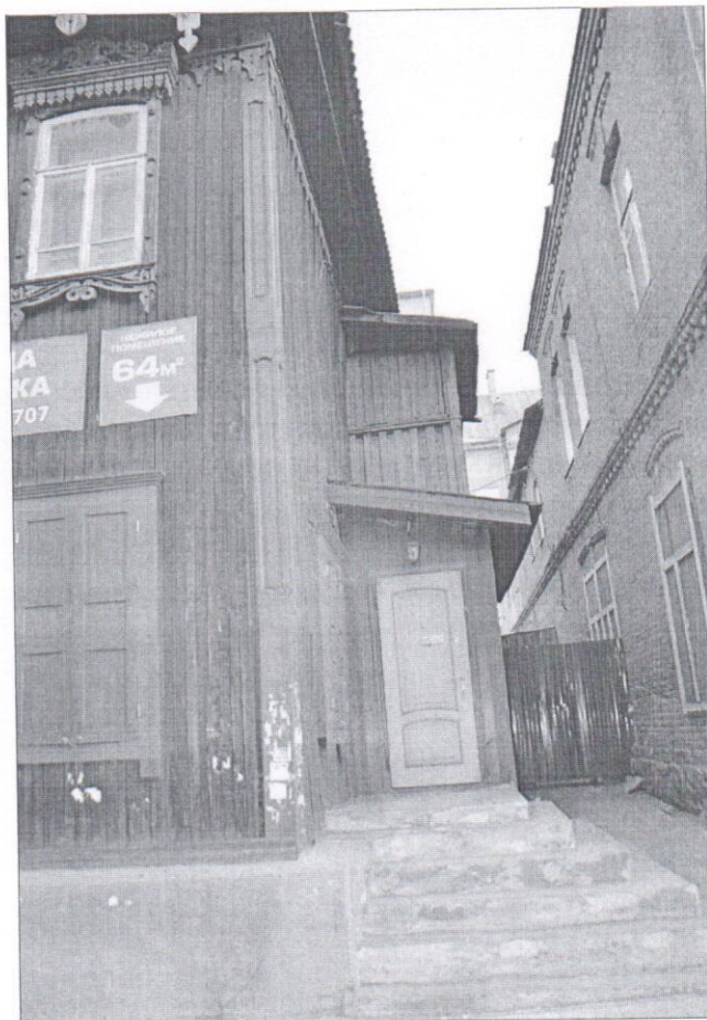
Фото 2 фрагмент юго-западного фасада, вход в пом 1.
