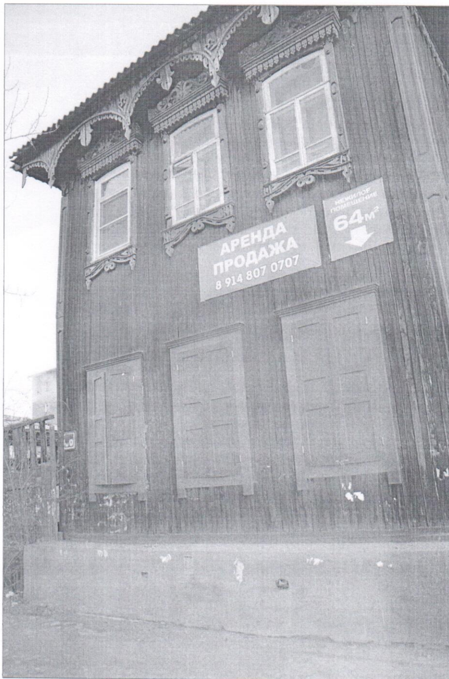
Фото1 главный юго-западный фасад.
