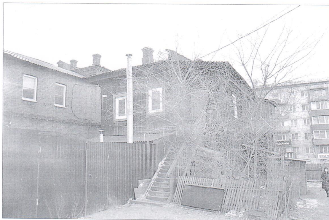
Фото 4 вид с севера, вход в кв. 5
