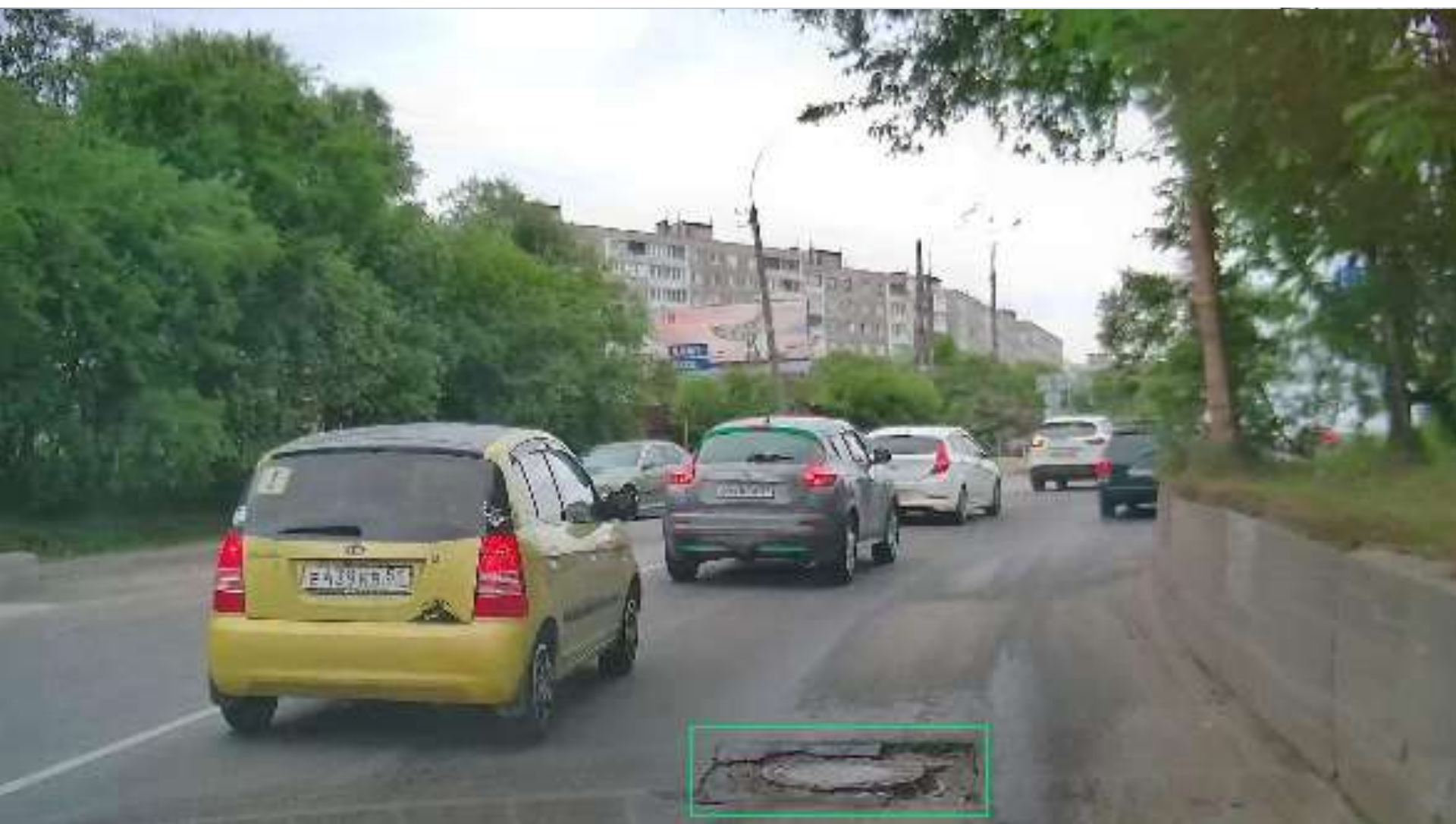
Провал/просадка канализационного люка
