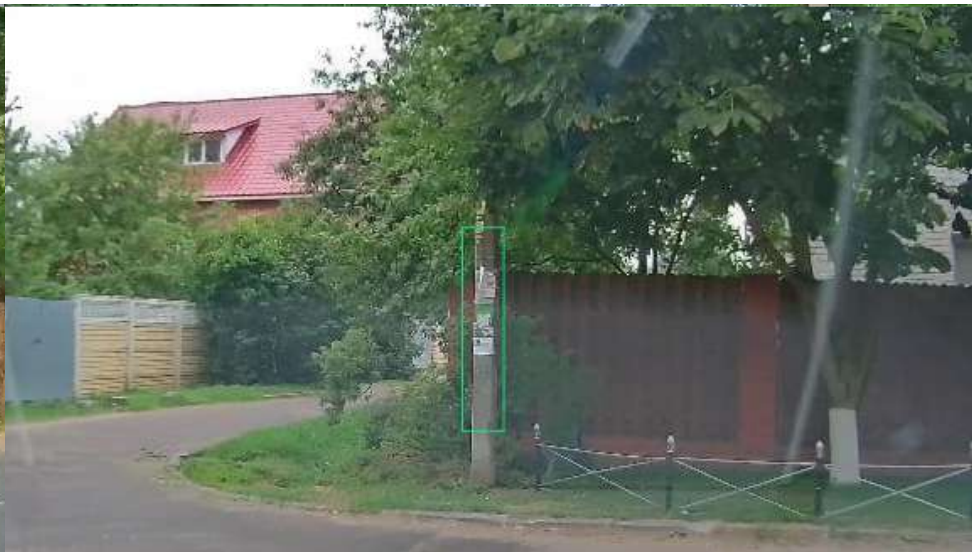
Грязная опора освещения
