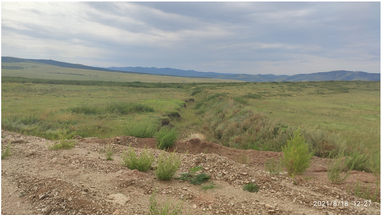
Рис. 5. Вид на свалку
