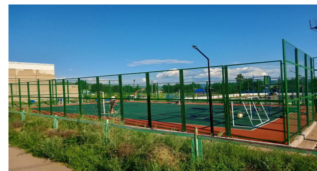
Завершение строительства спортивной площадки в п. Холбон
