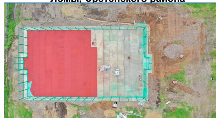
Завершается строительство универсальной спортивной площадки в с. Ломы, Сретенского района
