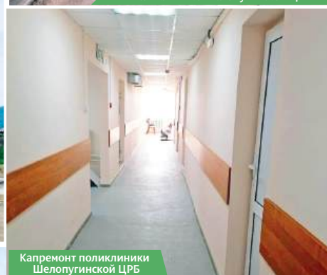
Начало капитального ремонта в поликлинике Шелопугинской ЦРБ
