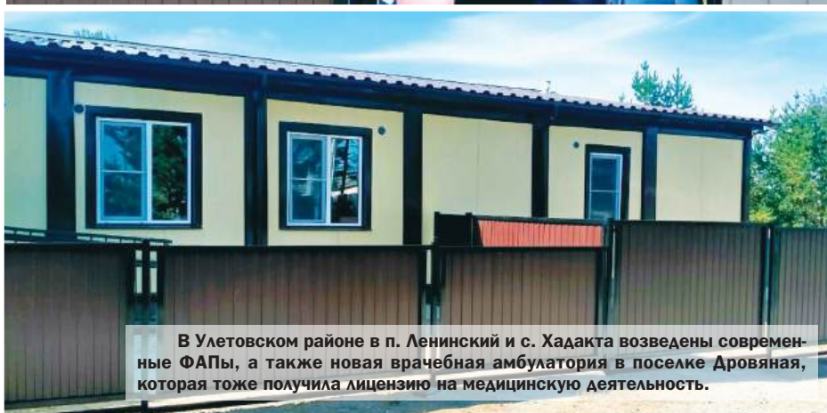
Завершилось строительство нового ФАПа в Улетовском районе – в поселке Ленинский. Перед открытием его оснастили оборудованием и мебелью.
