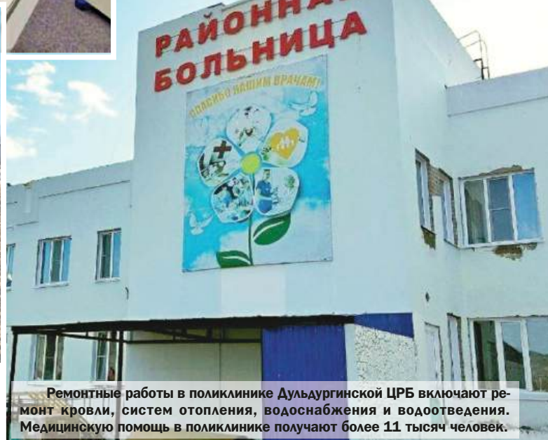
Около 3000 человек являются пациентами участковой больницы в п. Могзон Хилокского района. Здесь установят модульное здание больницы, будут организованы отдельные входы для детей и взрослых, регистратуры, кабинеты врачей, процедурные и прививочные, а также круглосуточный стационар.
