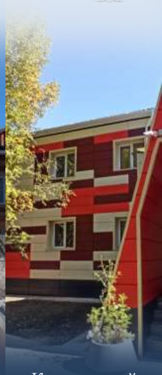
Капитальный ремонт 5 учреждений культуры
