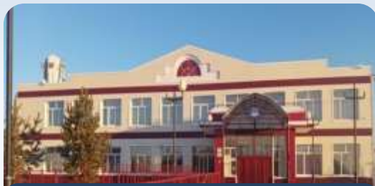
Капитальный ремонт культурно-досуговых учреждений
