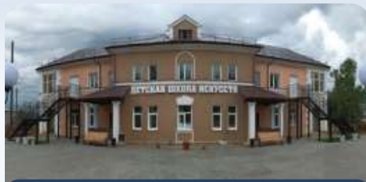
Капитальный ремонт детских школ искусств
