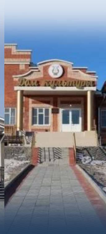
Строительство 3 домов культуры
