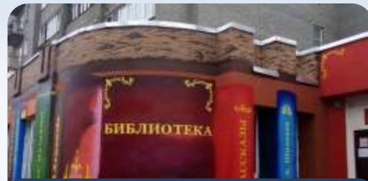
Капитальный ремонт библиотек
