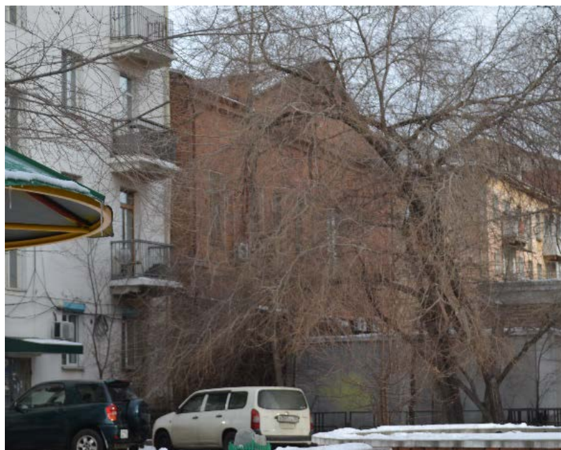
Рис. 10. Вид объекта культурного наследия «Жилой дом Бермана У. С.» с противоположной стороны ул. Журавлева (Точка 4 на Плане ландшафтно-визуального анализа)
