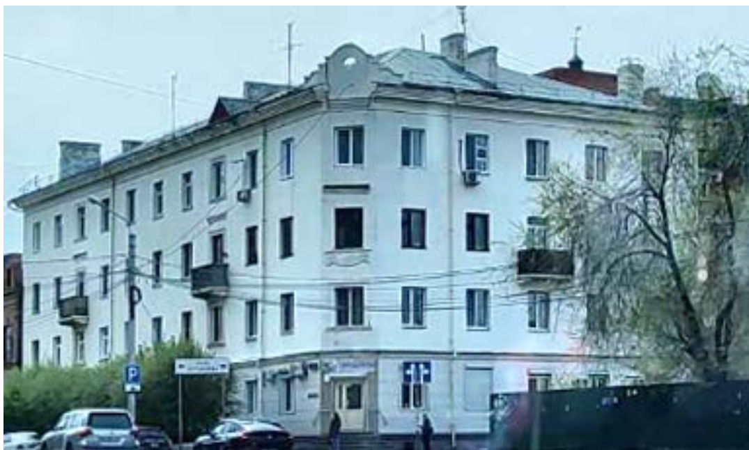
14. Многоквартирный жилой дом с магазином ул. Амурская, 111
