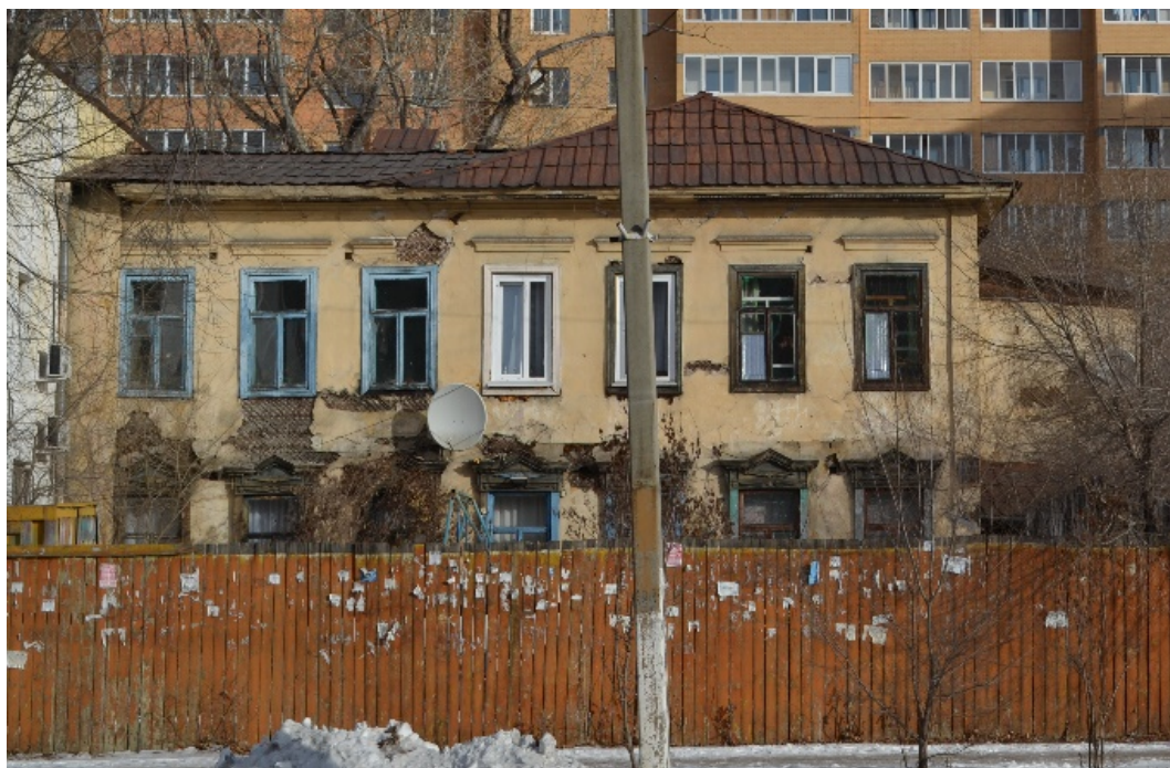
4. «Усадьба Назаровой» Жилой дом в усадьбе ул. Амурская, 104
