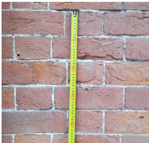
Рис.4. Замер кирпичной кладки здания по ул. Амурской,109
