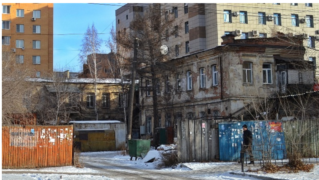
Рис. 28. Каменные службы в составе объекта культурного наследия «Усадьба Назаровой»
