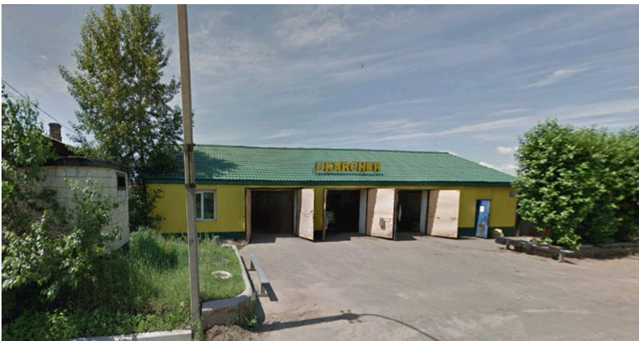
Фото 6. Общий вид – объект придорожного сервиса по адресу: ул. Кастринская, 17.
