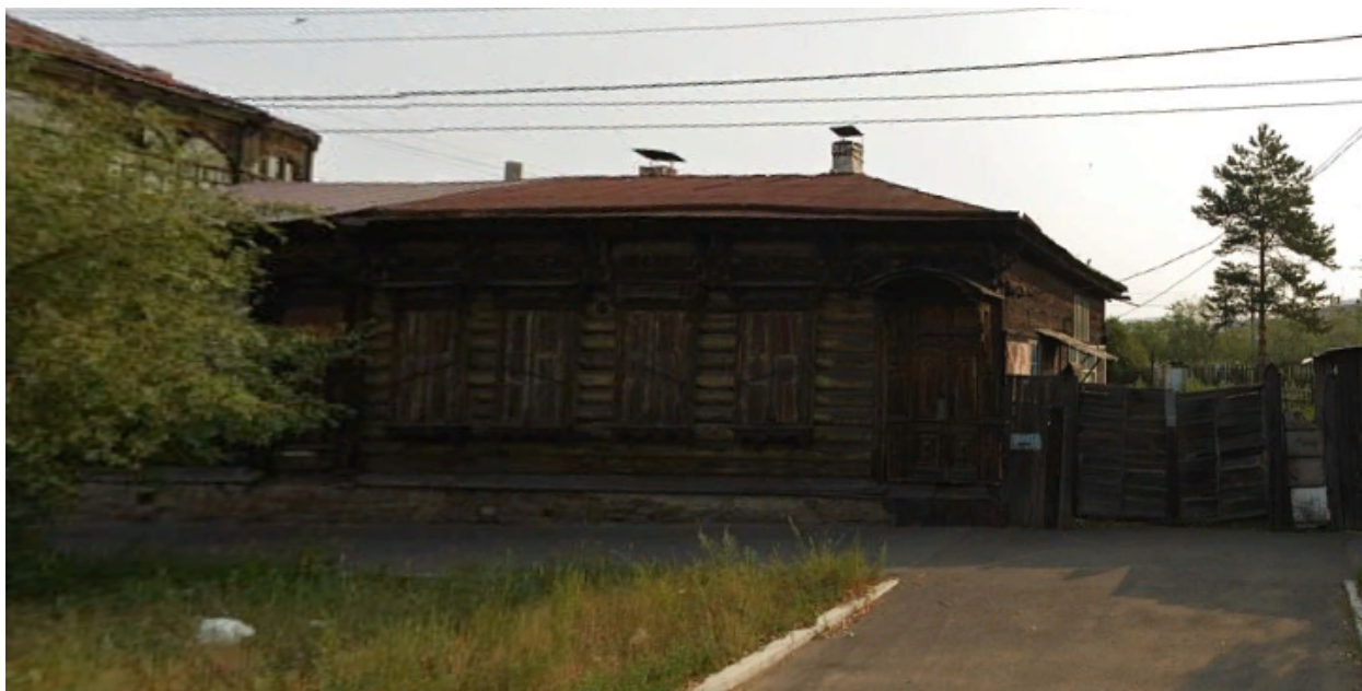
Фото 13. Общий вид – жилой дом (историческая функция) по адресу: ул. Кастринская, 14.
