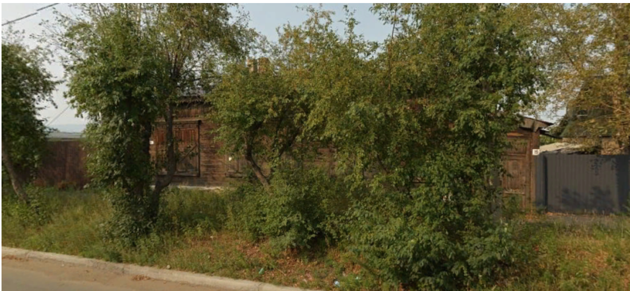
Фото 5. Общий вид – жилой дом по адресу: ул. Кастринская, 15.
