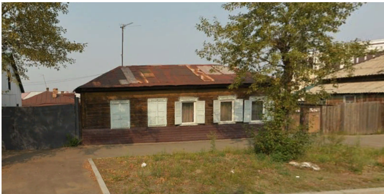
Фото 7. Общий вид – жилой дом по адресу: ул. Кастринская, 19.
