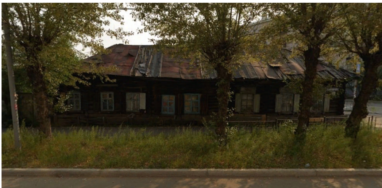
Фото 3. Общий вид - жилой дом по адресу: ул. Кастринская, 10.
