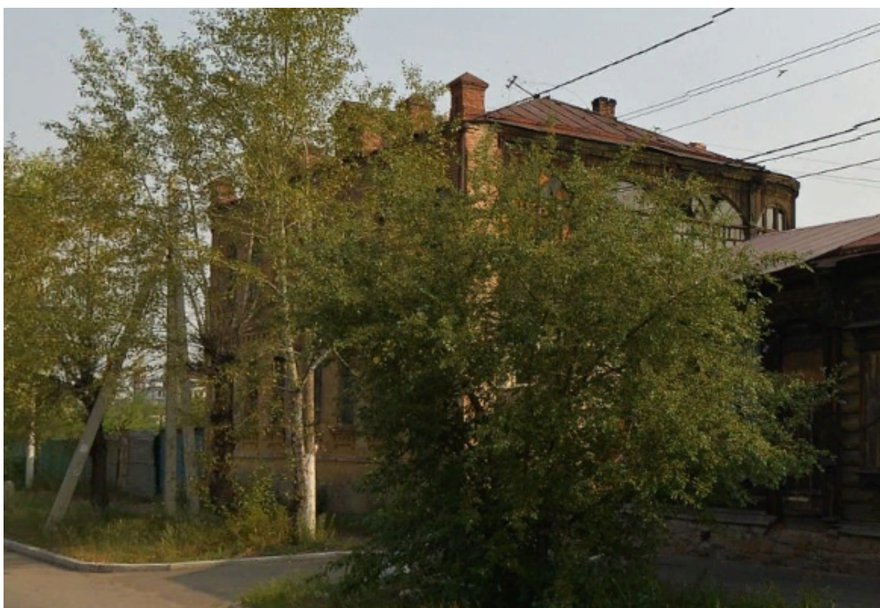
Фото 12. Общий вид – жилой дом (историческая функция) по адресу: ул. Кастринская, 16.
