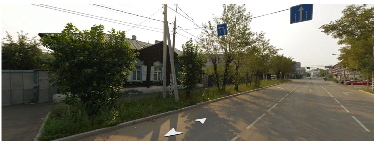
Фото 13. Общий вид – жилой дом (историческая функция) по адресу: ул. Кастринская, 12.
