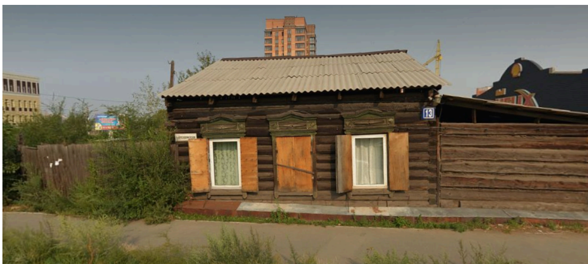
Фото 10. Общий вид – жилой дом (боковой фасад) по адресу: ул. Красноармейская, 11
