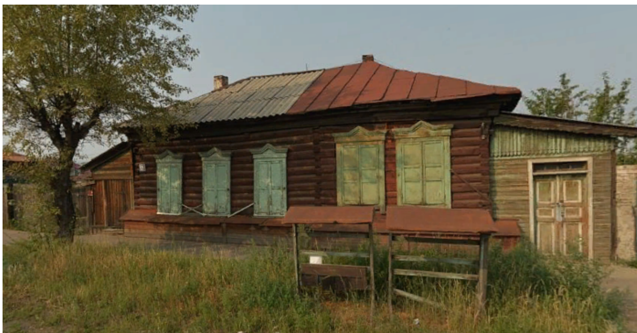
Фото 8. Общий вид – жилой дом по адресу ул. Кастринская, 21.
