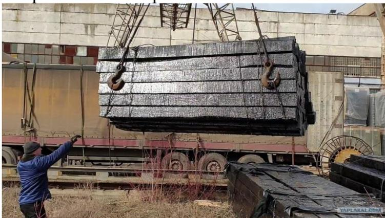
проследовал к осмотру места для выгрузки следующего «пакета» шпал. Когда пострадавший проходил между штабелями, со штабеля высотой 2.40 м на него упала незакрепленная сместившаяся при перемещении «пакета» железобетонная шпала.
